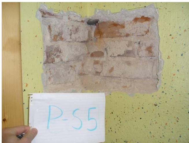
Slika 5: Zidna preiskovalna sonda povzeto po (Bartol Pohl, 2005)
