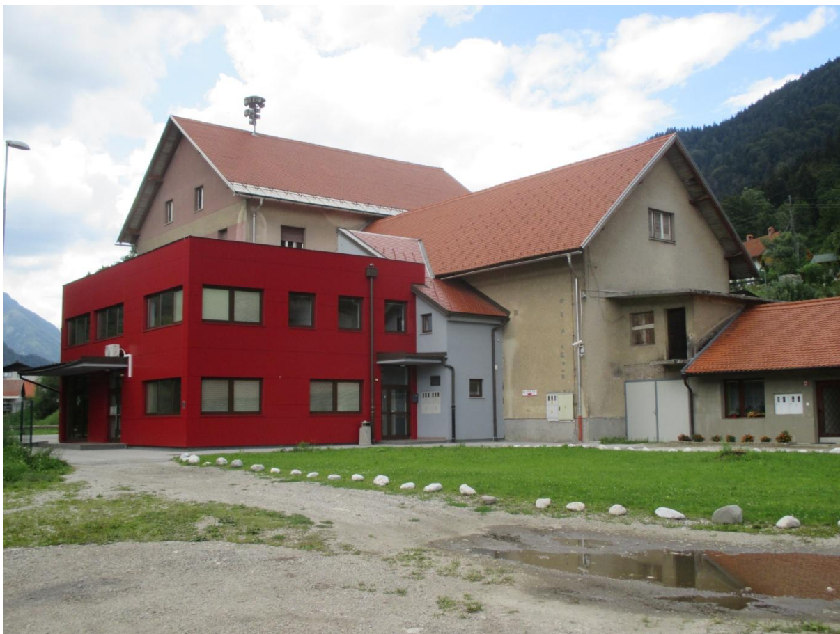
Slika 10: Kulturni dom Hrušica (obnovljen in funkcionalno preurejen)
