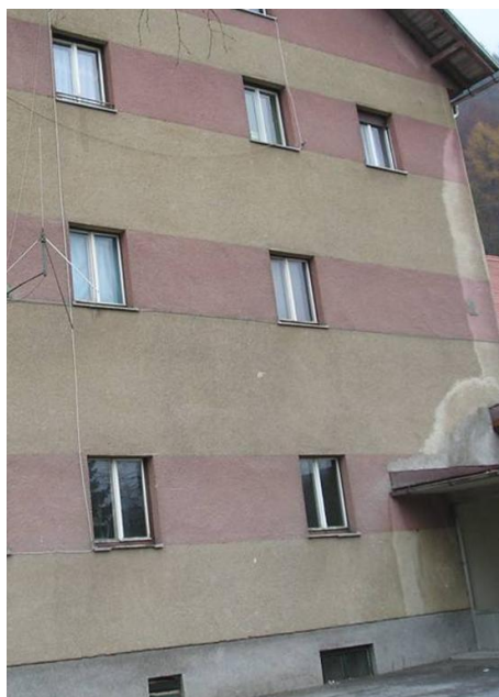
Slika 7: Izločanje mineralnih soli, stara okna, fasada brez TI povzeto po (Bartol Pohl, 2005)
