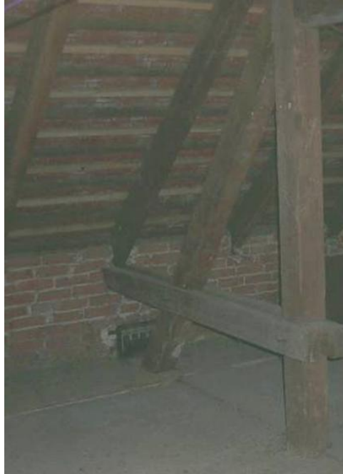
Slika 8: Odsotnost AB horizontalne vezi povzeto po (Bartol Pohl, 2005)
