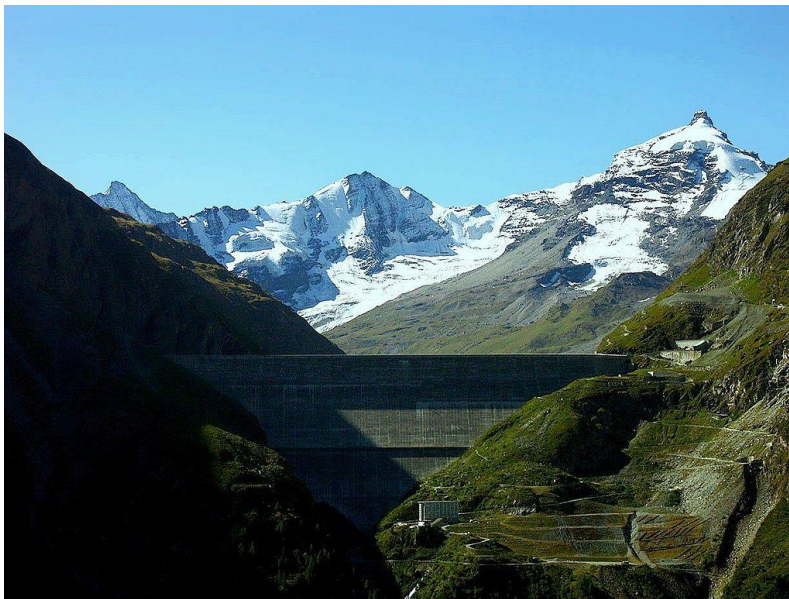
Slika 1: Najvišja betonska težnostna pregrada Grand Dixence 285 m, Švica (Vir: http://en.wikipedia.org/wiki/Grande_Dixence_Dam )
