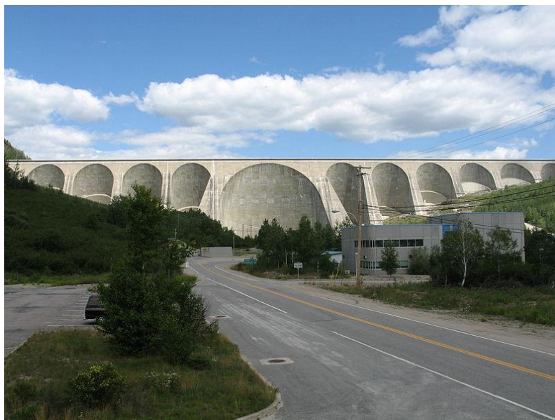
Slika 2: Najvišja olajšana betonska pregrada Daniel Johnson 214 m, Kanada (Vir: http://en.wikipedia.org/wiki/Daniel-Johnson_Dam )
