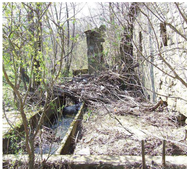
Slika 11: Dovodni kanali mlina danes (lasten vir)
