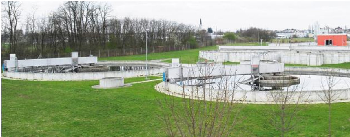
Slika 4: Čistilna naprava Murska Sobota
