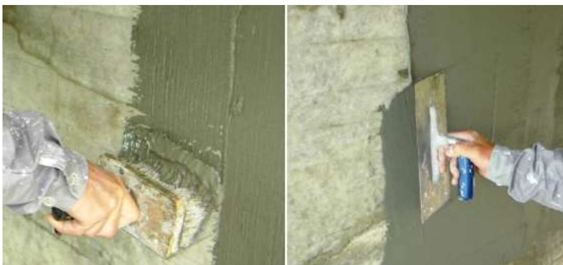
Slika 15: Nanašanje fine sanacijske malte z čopičem (levo) in kovinsko gladilko (desno)
