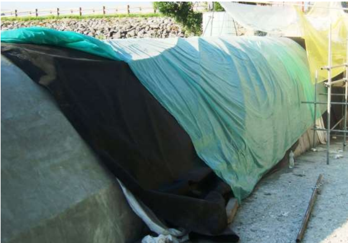
Slika 16: Zaščita svežega nanosa pred prehitrim izsuševanjem z PVC folijo
