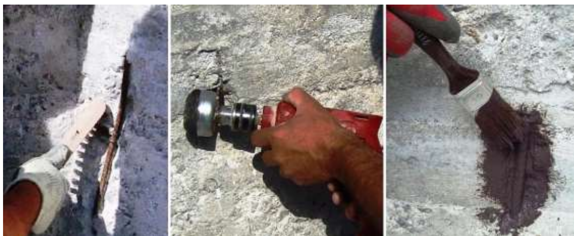
Slika 10: Postopek čiščenja in zaščite armature
