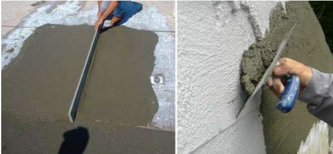
Slika 13: Nanašanje grobe sanacijske malte na talne (levo) in stenske površine (desno)
