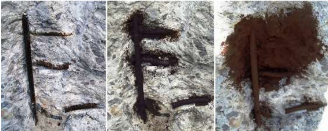
Slika 11: Zaščita armature z maso BETONPROTEKT K2
