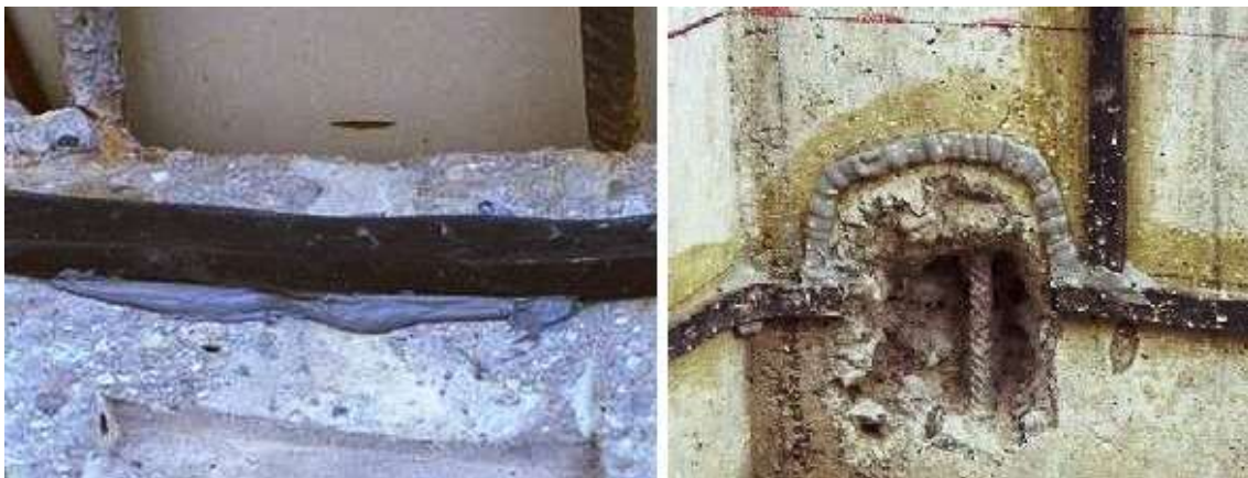
Slika 22: Prikaz uporabe nabrekajočega tesnilnega traku v kombinaciji z nabrekajočim tesnilnim kitom
