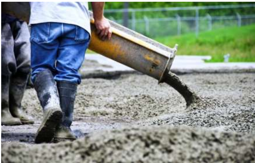
Slika 1: Proces vgradnje betonske mešanice
