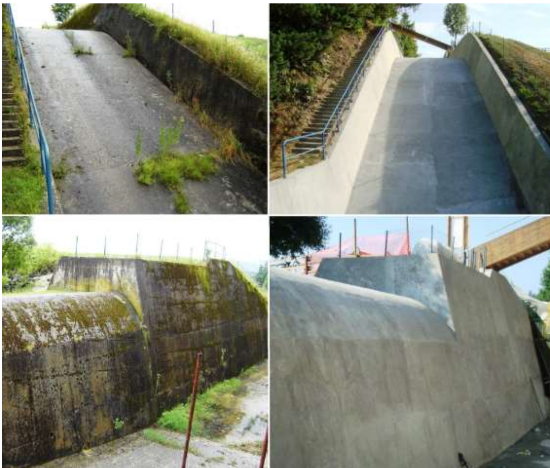
Slika 5: Izgled površine elementov AB izpusta pred (levo) in po sanaciji (desno)
