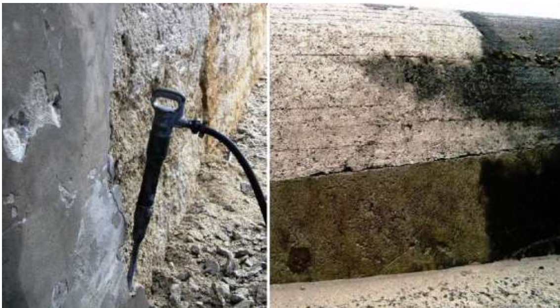
Slika 9: Priprava podlage z uporabo pnevmatskega kladiva (levo) in visokotlačnega vodnega curka (desno)
