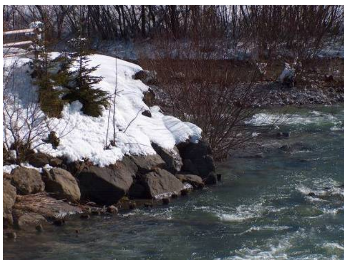
Slika 16: Kamnometna ločilna zgradba (foto:avtor, marec 2006)
