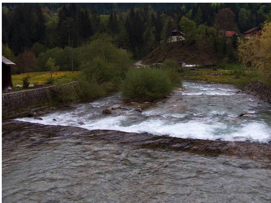
Slika 14: Dolvodno od mostu sta levi in desni breg varovana z zidom iz lomljenca v betonu (foto:avtor, maj 2006)
