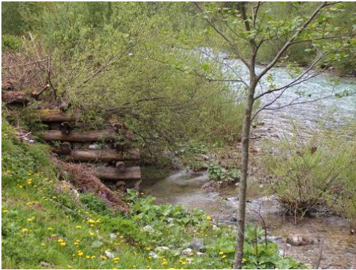
Slika 9: Poškodovana jezbrica
