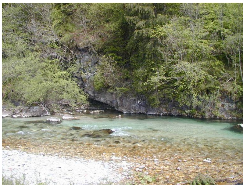
Slika 28: Mesto načrtovanega vtoka v razbremenilni predor (foto:IZVODE, junij 2005)
