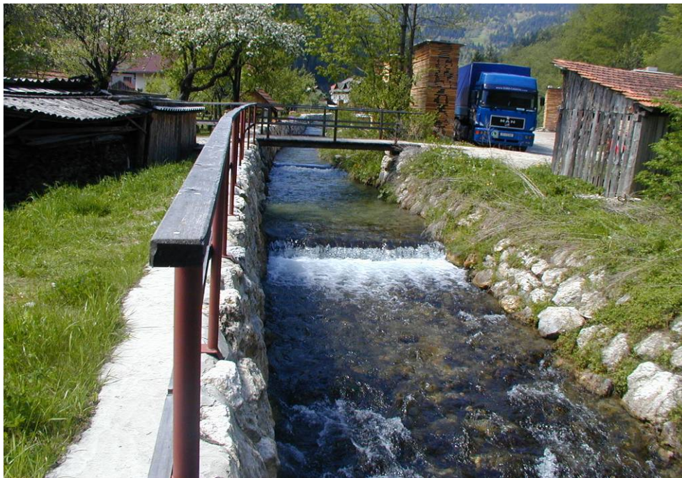
Slika 11: Zid ob DB izlivnega dela mlinščice Struge (foto:IZVODE, april 2004)
