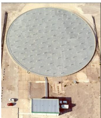
Slika 37: Instalacija sprejemnih anten sistema GRAVES v Atp
