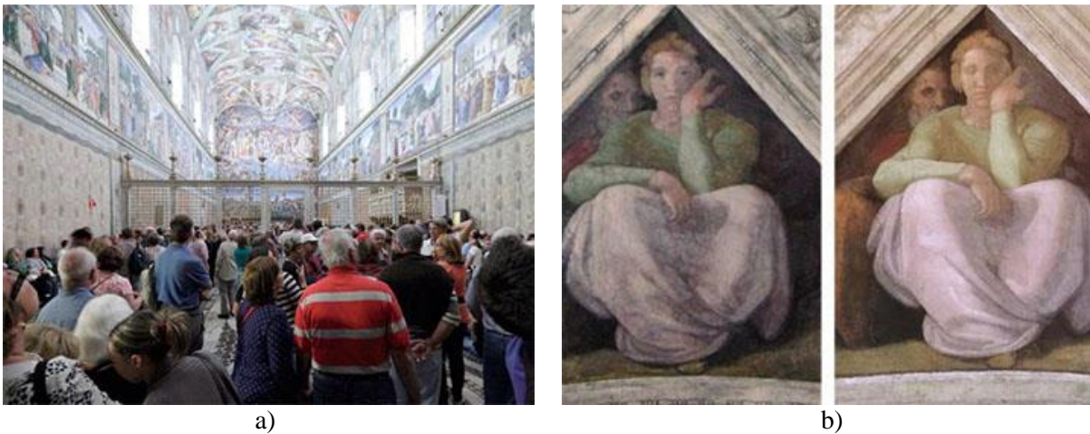
Slika 69: a) množica turistov v Sikstinsko kapelo prinaša prah in umazanijo ter zvišuje temperaturo in vlažnost, b) zaradi umazanije potemnela freska, desno očiščena
