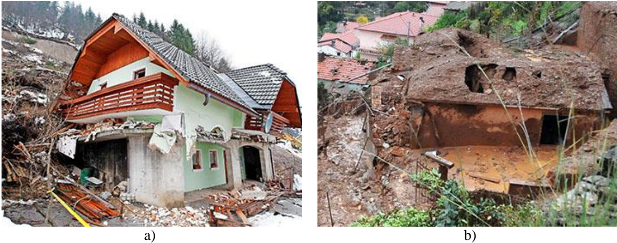
Slika 58: a) porušitev stavbe v Bohinju, 2008, b) opustošena stavba v kraju Massa po sprožitvi zemeljskega plazu zaradi obilnega deževja, 2010
