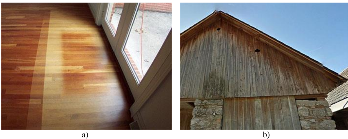
Slika 32: a) bledenje lesa na nepokritih mestih, b) sivjenje lesa pod vplivom sonca in drugih okoljskih dejavnikov
