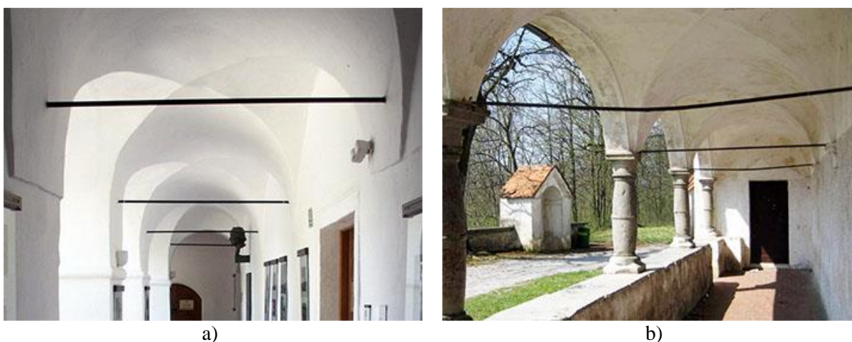
Slika 36: a) vezi na obokanem hodniku, Olimje, b) popuščena vez na obokanem hodniku, cerkev sv. Trojice, Vrhnika
