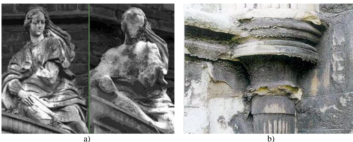
Slika 34: a) posledice kislega dežja - desna slika je posneta 60 let kasneje, b) črna skorja na apnencu
