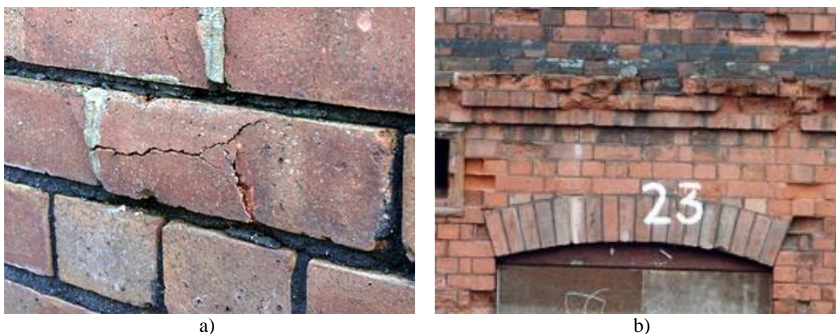
Slika 19: a) razpoke v opeki zaradi zmrzali, b) odpadanje opeke kot posledica zmrzali
