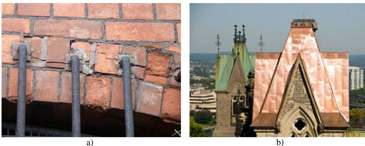
Slika 26: a) razpoke v opeki zaradi rjavenja železa, b) nov neoksidiran baker spredaj in značilna patina v ozadju
