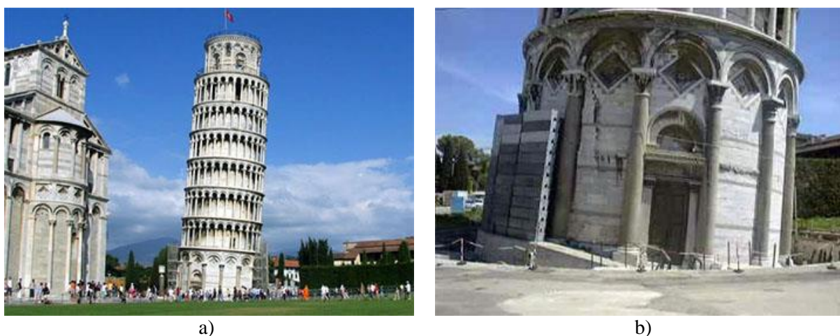
Slika 39: a) nagibanje stolpa v Pisi zaradi stisljive gline, b) začasno nameščene svinčne uteži
