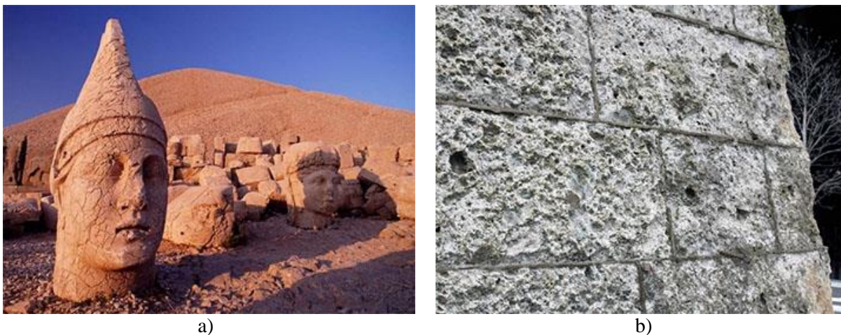
Slika 17: a) kipi iz apnenca na gori Nemrut, Turčija, so pod vplivom temperaturnih nihanj, ciklov močenja in sušenja ter zmrzovanja in tajanja, vetra, snega in sončnega obsevanja močno poškodovani, b) preperevanje kamna pod različnimi vplivi okolja
