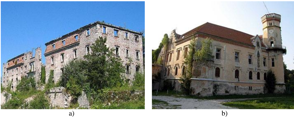
Slika 77: a) razvalina gradu Hošperk, požganega leta 1944, b) grad Slivnica je po končanem denacionalizacijskem postopku ostal v državni lasti, a že dve desetletji zapuščen propada
