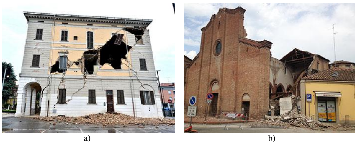
Slika 52: a) poškodbe mestne hiše v kraju Sant'Agostino po potresu leta 2012, b) porušena cerkev v Mirandoli
