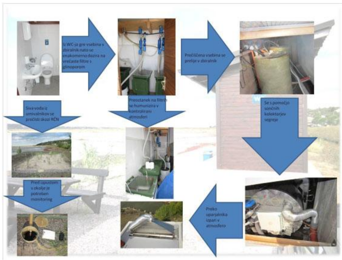
Slika 42: Shematski prikaz delovanja čistilnega sistema SANBOX. [2]
