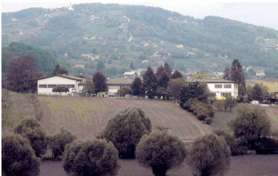
Slika 2: Pogled na stavbo z južne strani (vir: lasten)
