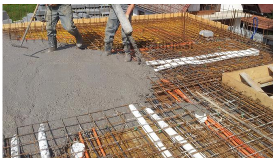
Slika 4-3: Masivna AB plošča ( http://www.pasivnogradnja.com , 2014)
