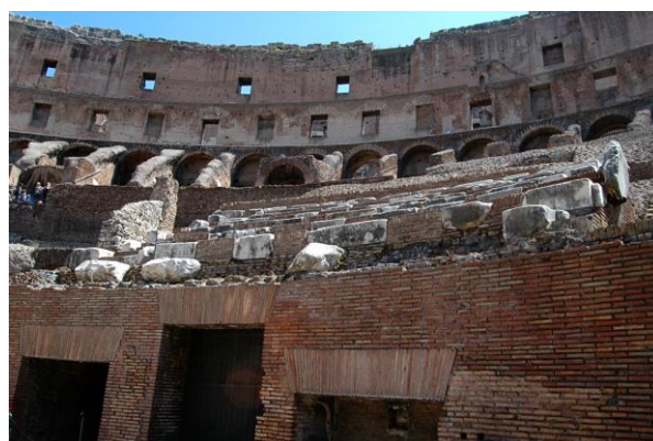
Slika 2-2: Kolosej v Rimu, zgrajen iz travertina, tufa in opeke
