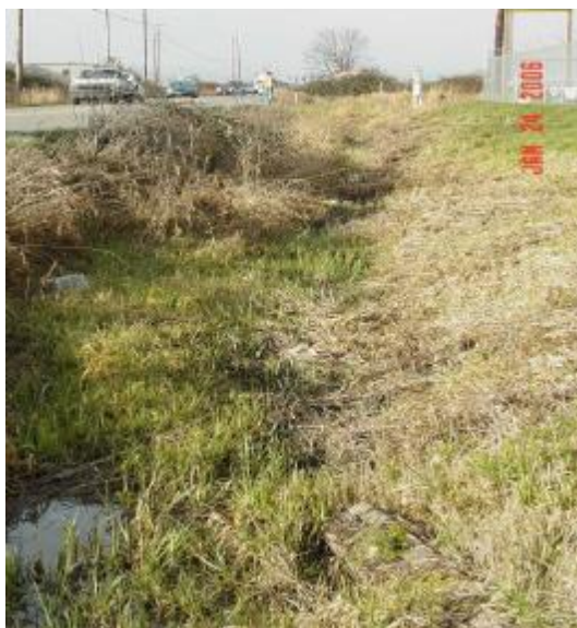
Slika 14: Vlažen biofiltracijski kanal (HRM, 2011, str. 5-58)
