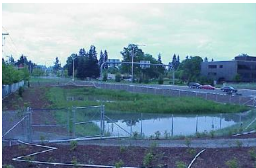
Slika 19: Kombinirani mokri zadrževalnik/usedalnik (HRM, 2011, str. 5-84)
