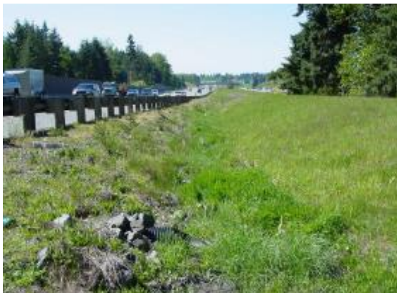
Slika 15: Biofiltracijski kanal z neprekinjenim dotokom (HRM, 2011, str. 5-81)
