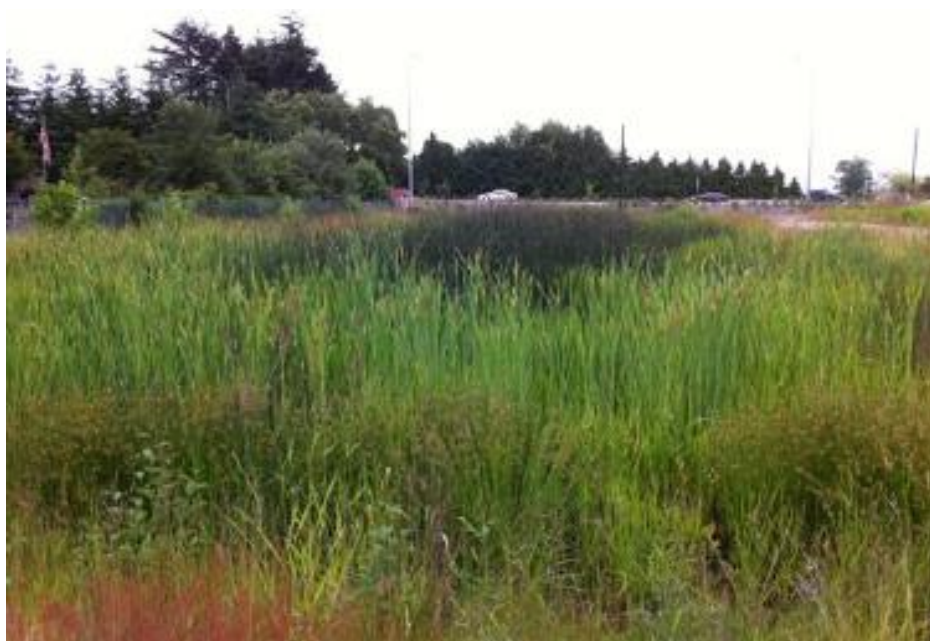
Slika 21: Umetno Mokrišče za čiščenje PV s cest (HRM, 2011, str. 5-100)
