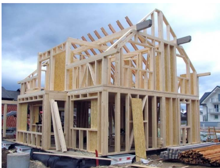
Slika 14: Primer lesene skeletne nosilne konstrukcije ( http://www.jaris.si/slo/kako-bo-rasla-vasa-hisa/skelet/ )
