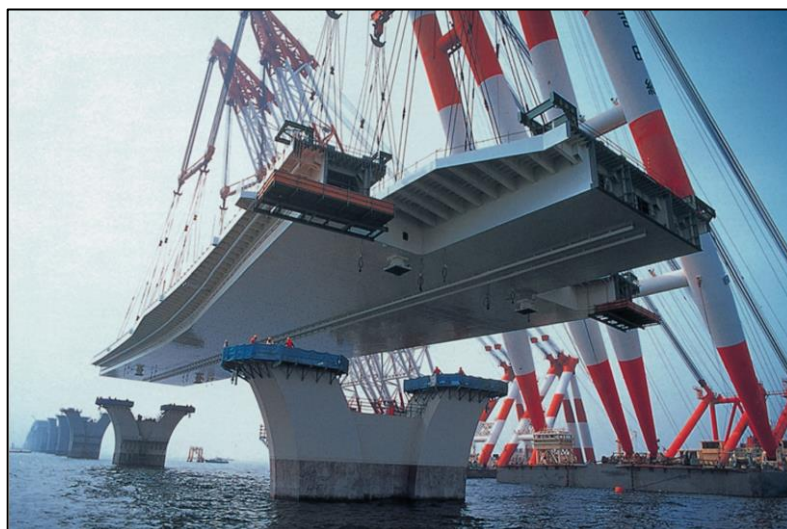
Slika 1- Ojačen škatlast nosilec mostne konstrukcije ( http://www.yokogawa-bridge.co.jp/english/05_steelbridges/index6.html pridobljeno 4.4.2014)
