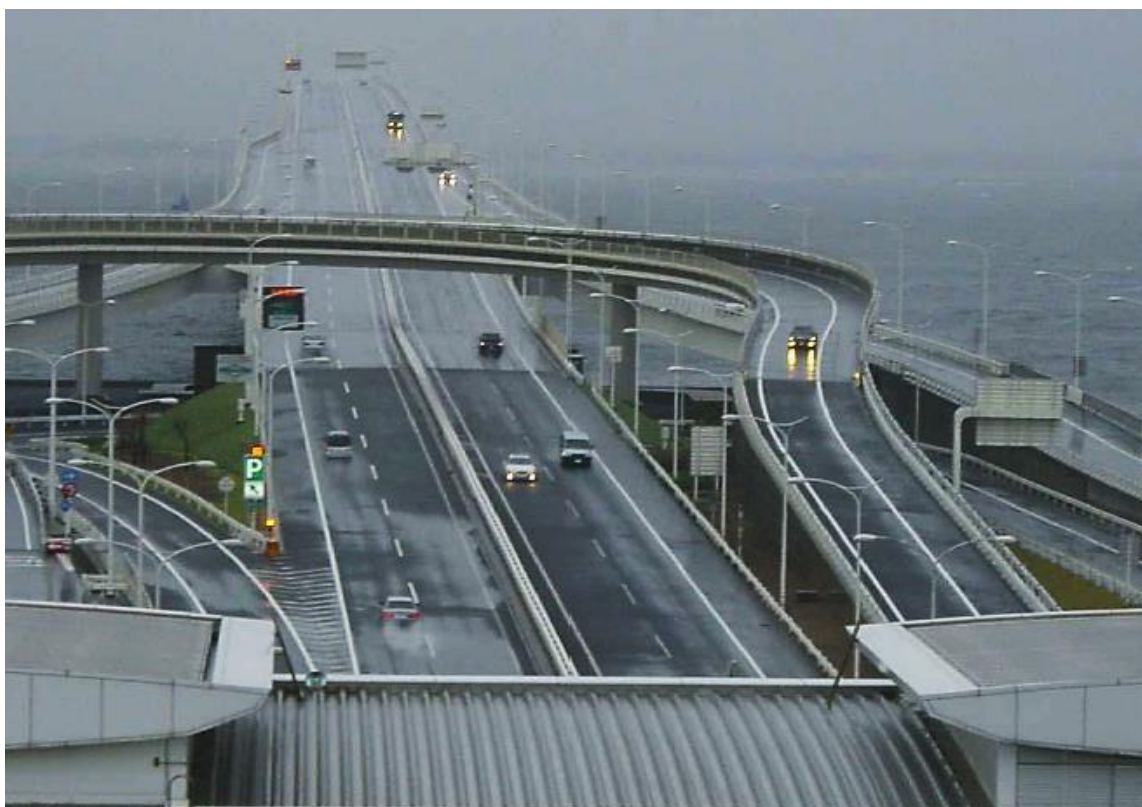
Slika 43: Zmanjšanje odboja svetlobe iz vozne površine (Takahashi, Partl, 2006).
