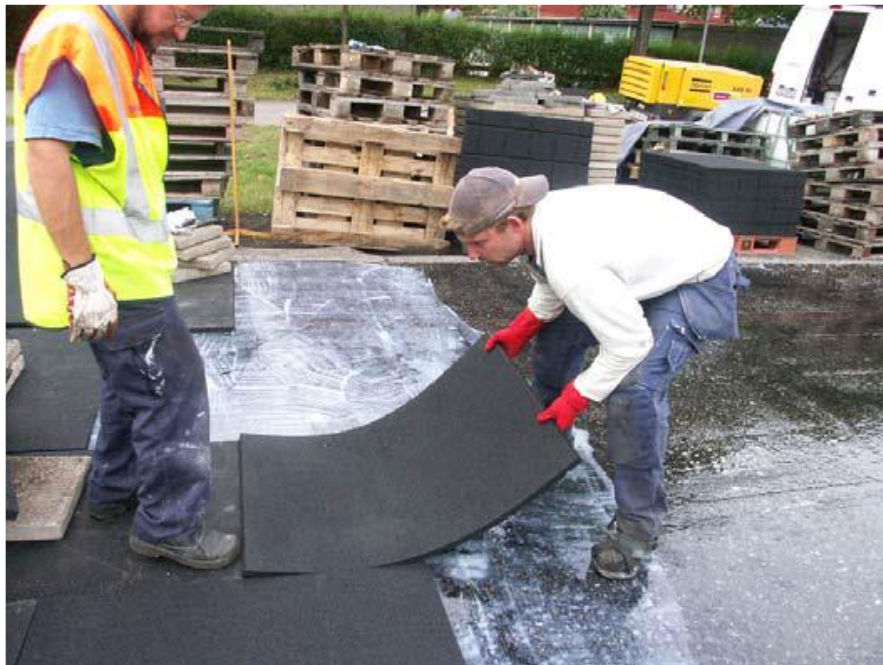
Slika 47: Primer vgradnje elastične drenažne podlage.
