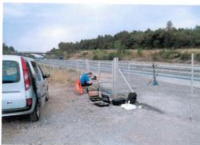
Slika 1: Lokacija meritev obrabne plasti vozišča SMA 11
