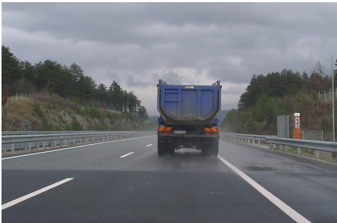
Slika 42: Lepo viden prehod iz drenažne v nedrenažno podlago.
