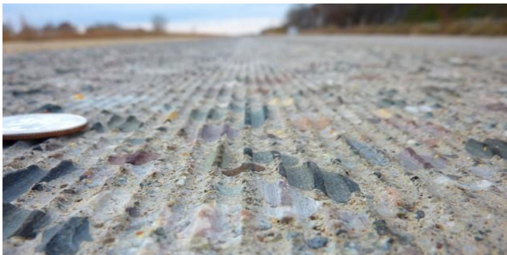
Slika 34: Videz žlebičenja vozne površine.
