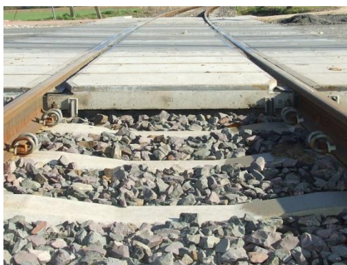
Slika 56: Prehod med klasičnim in Edilon sistemom (Vir: http://www.garneki.pl/liseczek/17935490/system-szyny-w-otulinie-edilon (22.8.2013))
