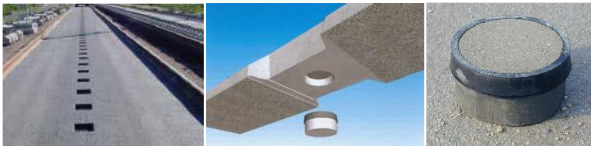
Slika 33: Reže v asfaltni plasti in betonski prag s sidrnim blokom, sidrni blok (Vir: Lakušič, Vajdič, 2010)
