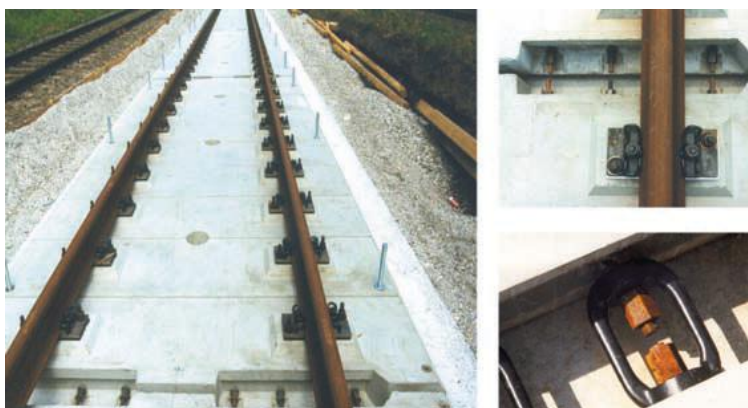
Slika 40: Plošča sistema Bögl (Vir: Esveld, 2003)
