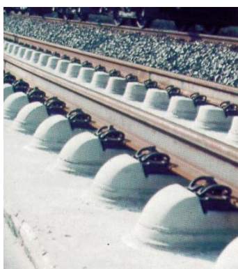
Slika 52: Sistem Hochtief, Schreck-Mieves na testnem odseku (Vir: Mörscher, 1999)
