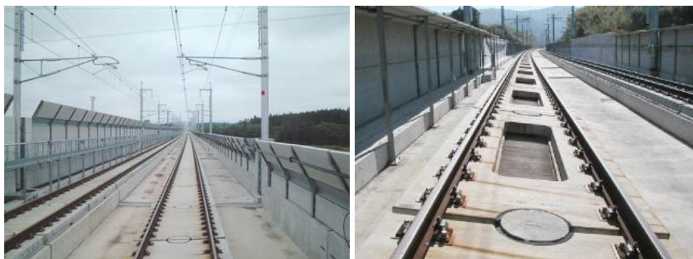
Slika 38: Proga z ravnimi ploščami in plošče v obliki okvirja (Vir: http://www.jrft.go.jp/11English/pdf/p_rw_010.pdf (15.8.2013))
