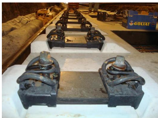
Slika 82: Pritrdilni pribor Vossloh 300-1 (Vir: Srebot, 2010)
