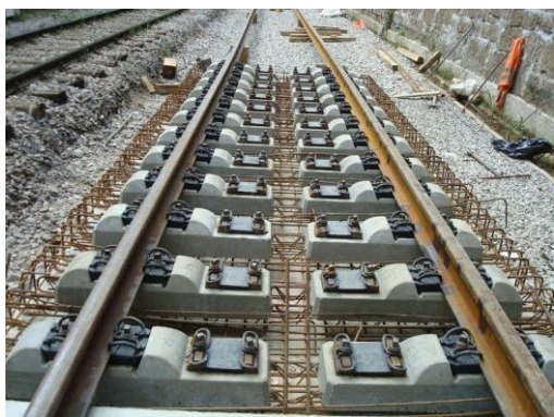
Slika 89: Armatura prehodne konstrukcije (Vir: Srebot, 2011)
