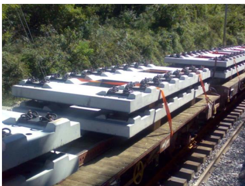
Slika 70: Betonske plošče sistema ÖBB-Porr (Vir: Tiring, 2010)
