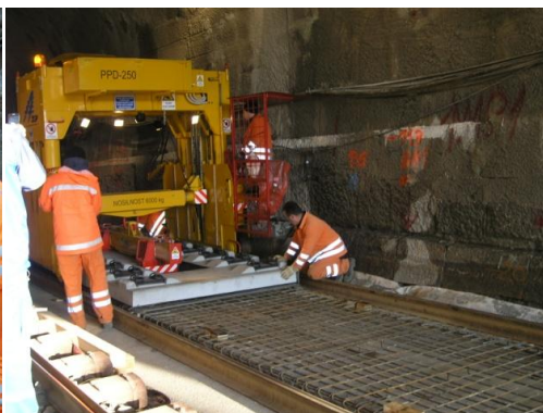
Slika 79: Polaganje betonskih plošč (Vir: Tiring, 2010)
