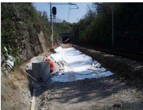
Slika 73: Polaganje geotekstila (Vir: Tiring, 2010)
