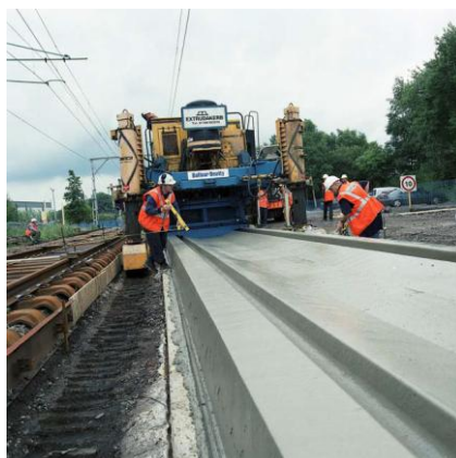
Slika 59: Betonska plošča z utoroma (Vir: Penny, Ingham, 2003)
