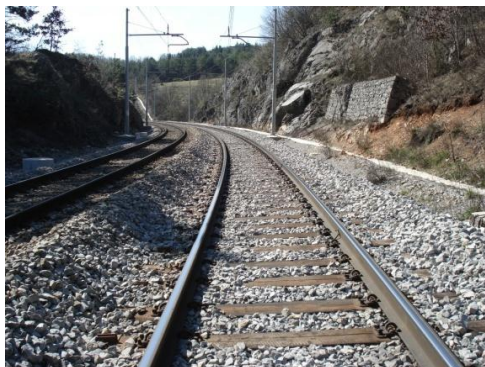
Slika 4: Klasična sestava železniške proge (Vir: Golob, 2014)
