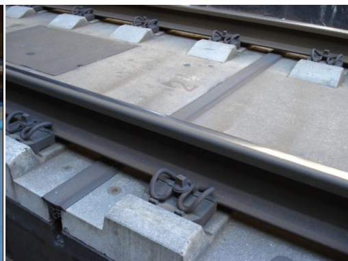
Slika 81: Dilatacija med dvema ploščama (Vir: Golob, 2014)
