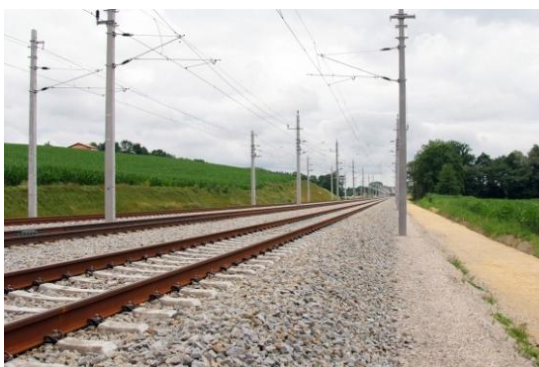
Slika 6: Zgornji ustroj klasične proge (Vir: http://www.plassertheurer.com/en/machines-systems (8.10.2013))
