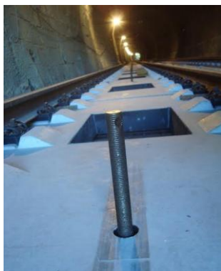
Slika 80: Vreteno M36 (Vir: Srebot, 2011)
