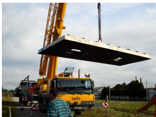
Slika 76: Kamionsko dvigalo (Vir: Tiring, 2010)
