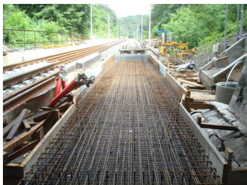
Slika 74: Armatura nosilne plasti (Vir: Srebot, 2011)
