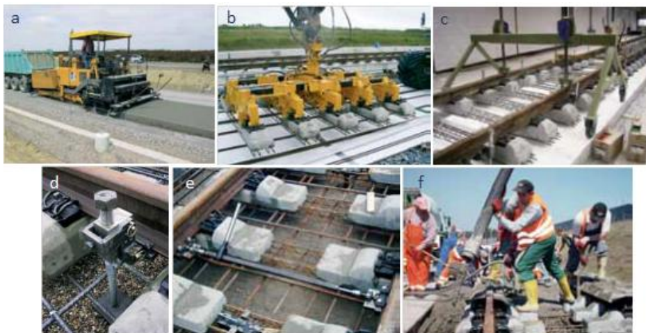
Slika 17: Vgradnja sistema Rheda 2000
