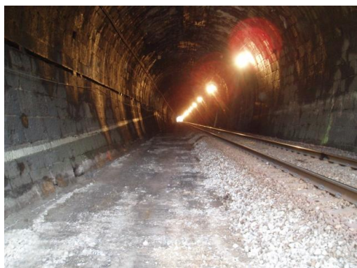
Slika 72: Očiščeno dno predora (Vir: Tiring, 2010)
