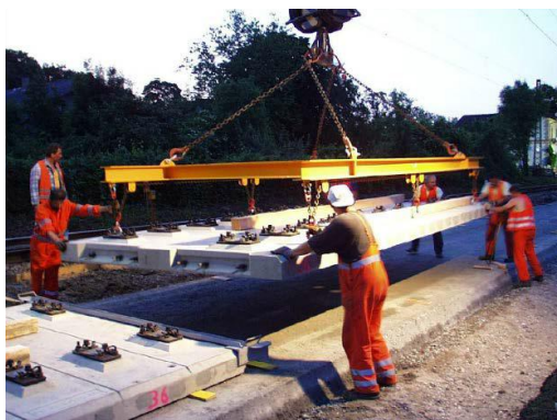
Slika 41: Polaganje montažnih plošč (Vir: http://pavement.wes.army.mil/papers/41/Presentation41.pdf (20.8.2013))
