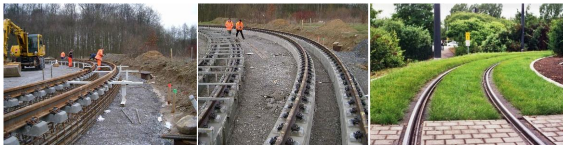
Slika 45: Sistem travnate proge (Vir: http://www.travetto.de/pdf/downloads/praes_rasengleissysteme.pdf (22.8.2013))
