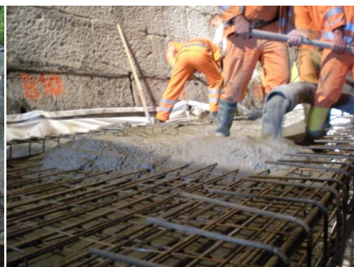
Slika 75: Vlivanje betona za nosilno plast (Vir: Tiring, 2011)
