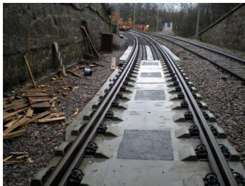
Slika 84: Proga po vlivanju podlivnega betona (Vir: Tiring, 2011)
