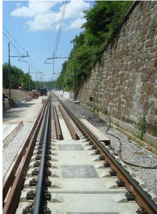
Slika 11: Dve dodatni tirnici na prehodu med klasičnim in togim tirom (Vir: Srebot, 2011)
