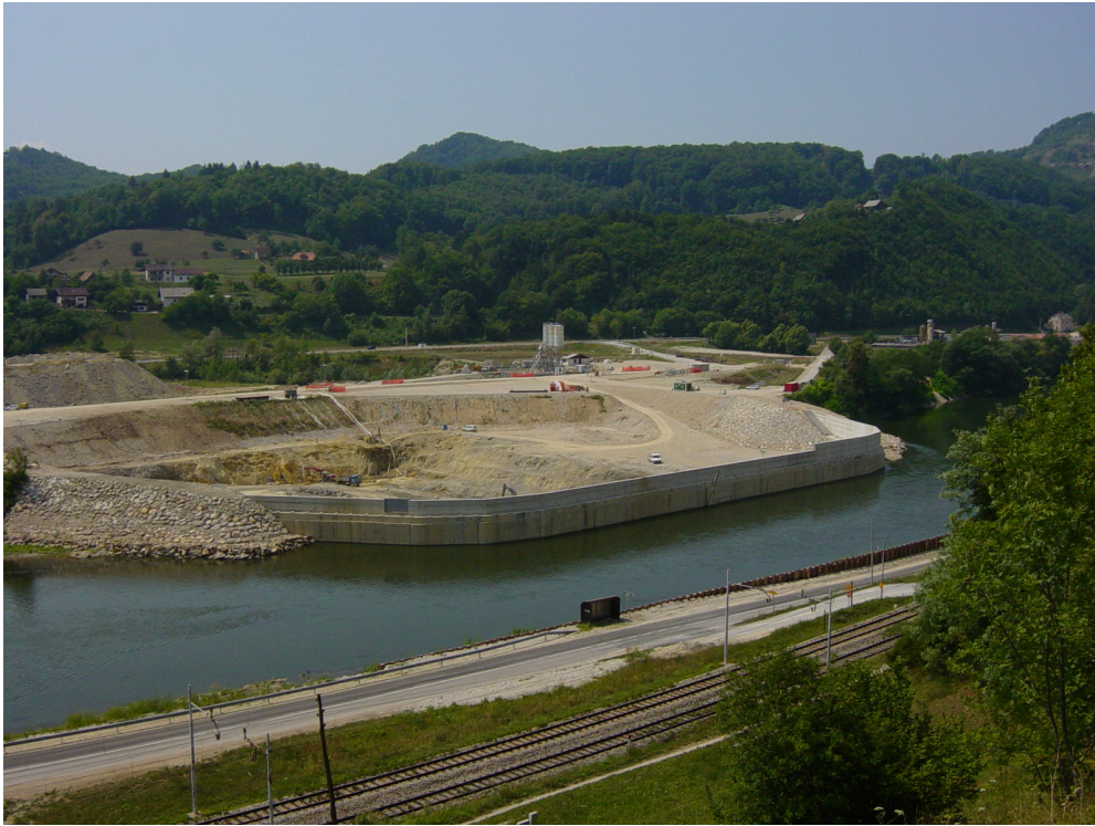
Slika 21. Fotografija gradbene jame na HE Boštanj
