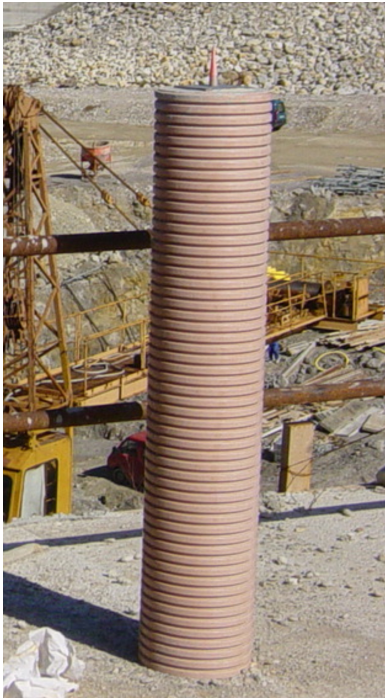
Slika 20. Primer stabilizacije opazovalnega stebra
