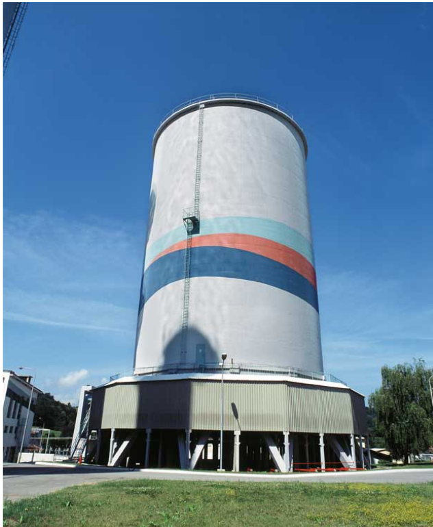
Slika 11. Blok termoelektrarne Brestanica
