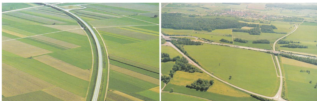
Slika 1: Vpliv velikih infrastrukturnih objektov na parcelno strukturo in krajino (levo); zmanjšanje negativnih vplivov posegov v prostor, ki so posledica velikih infrastrukturnih projektov, z ukrepom komasacije (desno) (vir: LGL-BW, 2000).
