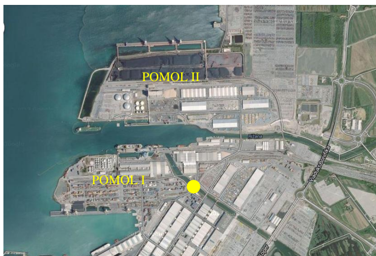
Slika 1: Lokacija mostu v Luki Koper (Google earth, 2014)
