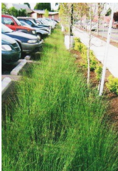
Slika 18: Primer ureditve poglobljenega zelenega pasu na parkirišču (Dunnett, Clayden, 2007)
