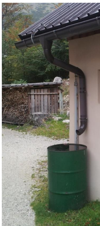
Slika 12: Preprosta ureditev zbiranja deževnice (Vir: Avtorica)
