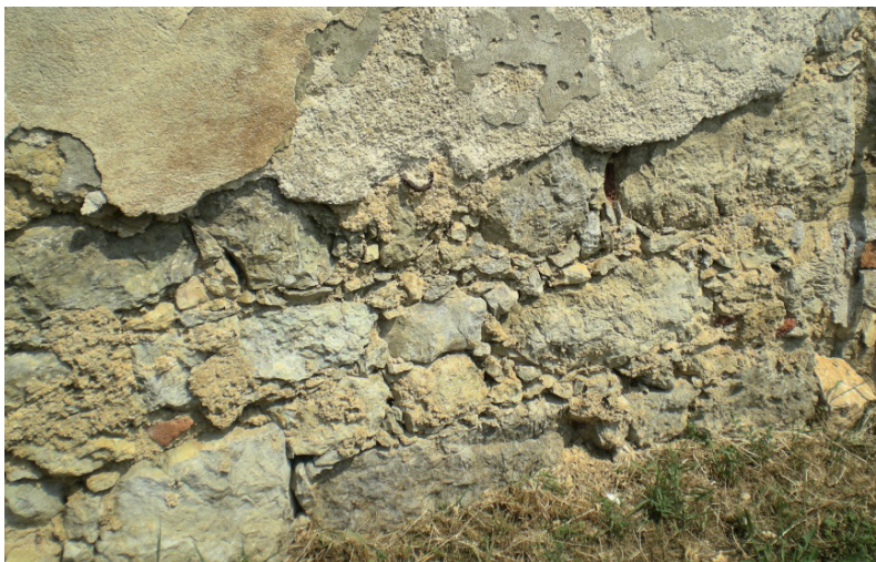
Slika 2.15: Sestava zidu v južnem traktu; kamniti bloki, nepravilnih oblik z debelimi vmesnimi spojnicami in vključki opek ter manjših kamnov.
