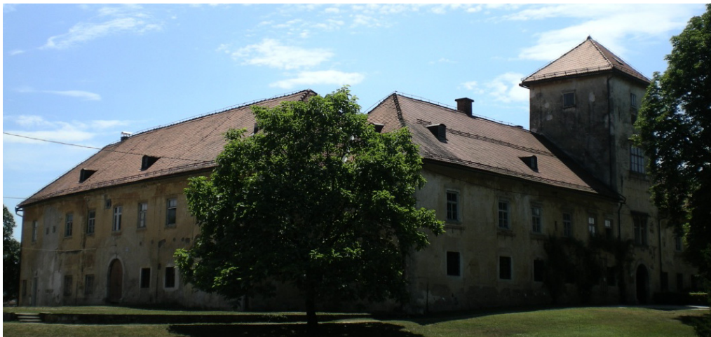
Slika 2.4: Pogled na severno in vzhodno fasado gradu
