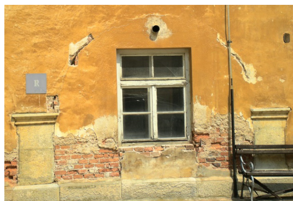
Slika 2.10: Zazidani arkadni loki: a) v nadstropju, pogled od znotraj, b) v pritličju, pogled z dvorišča.
