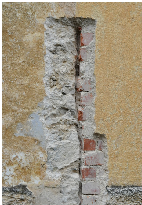
Slika 2.16: Stik novejšje opečne stene s starejšo kamnito na severni fasadi severnega trakta (vir ZVKDS, 2013b).
