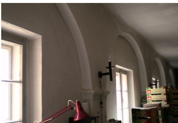
Slika 2.10: Zazidani arkadni loki: a) v nadstropju, pogled od znotraj, b) v pritličju, pogled z dvorišča.
