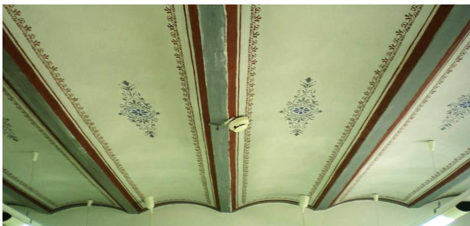
Slika 2.6: Obokan strop med vmesnimi železnimi nosilci (pruska čepica) v pritličju vzhodno od stolpa. Strop je okrašen s poslikavami.
