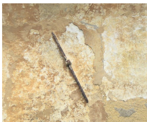
Slika 2.13: Vidna zidna železna vez na fasadi.
