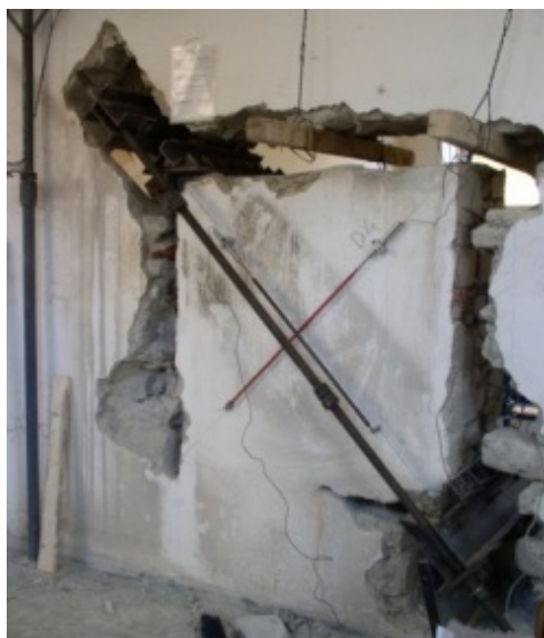
Slika 5.7: Diagonalni preizkus zidu
