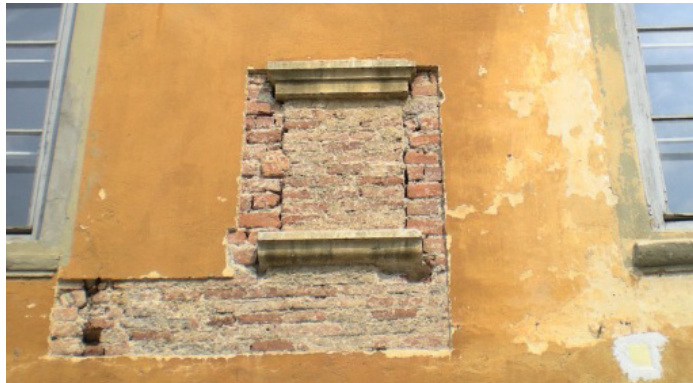
Slika 2.8: V nadstropju pozidani arkadni loki slonijo na opečnih stebrih.
