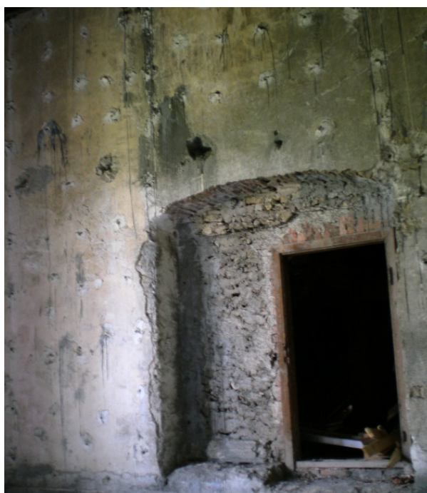
Slika 2.12: Injektirana stena stolpa nad stolpno dvorano.
