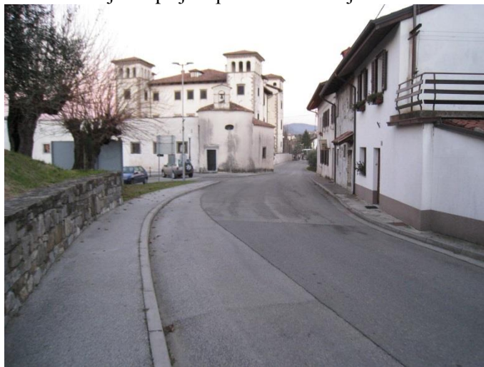
Slika 23: Lokalno zožanje vozišča na cesti LC-1
