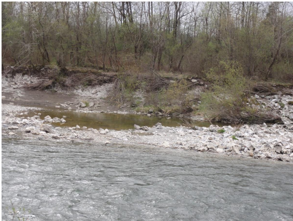
Slika 28: Erodirana rečna brežina s prodiščem (Neža Prosen, 5.4.2012)
