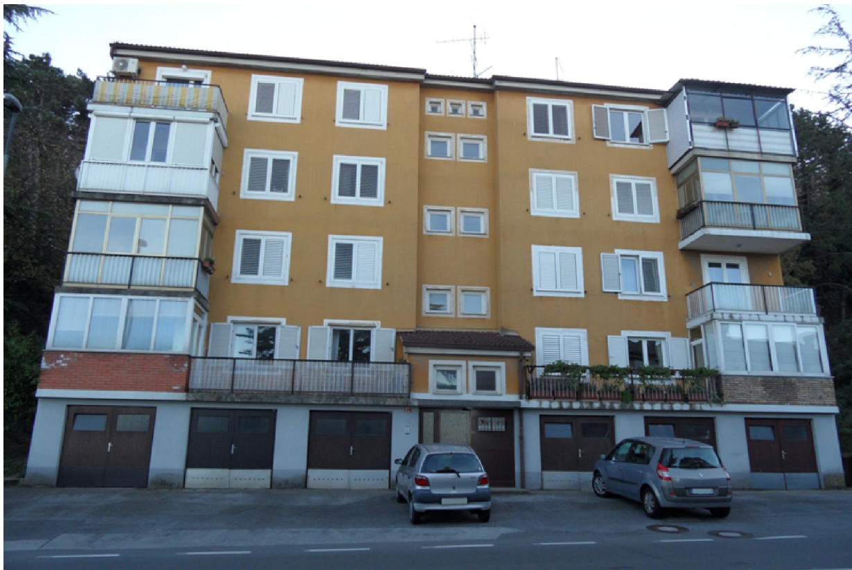
Slika 2: Slika obravnavanega večstanovanjskega objekta na Markovcu pri Kopru- severna fasada
