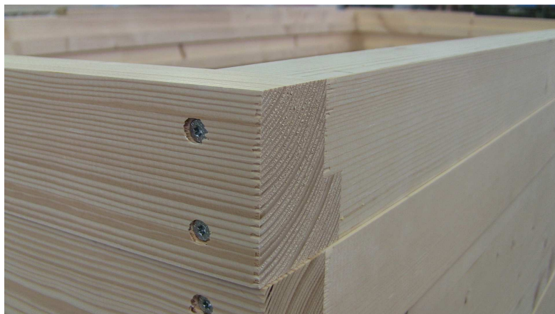
Slika 2.2 - Lesna vijaka 6/160 tipa HBS proizvajalca Rothoblaas, (pridobljeno od Boštjana Bera)
