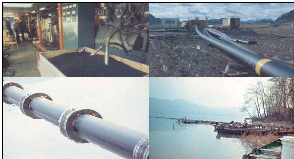
Figure 16: Pressure pipes inside lake during construction (Schulz, 2003) Slika 16: Tlačni vodi po dnu jezera med gradnjo (Schulz, 2003)
