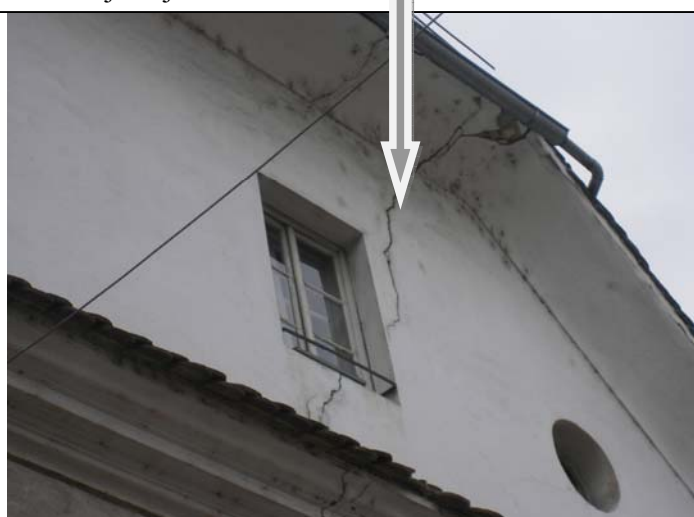
Slika 17: Razpoka na severni fasadi sodnije.
