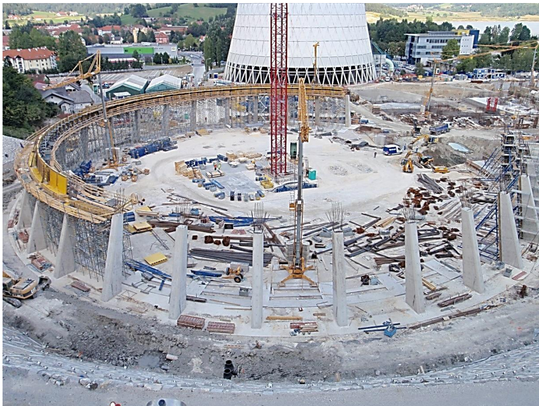
Slika 9: Stebri - nosilci lupine hladilnega stolpa (Rudis d.o.o., 2011)
