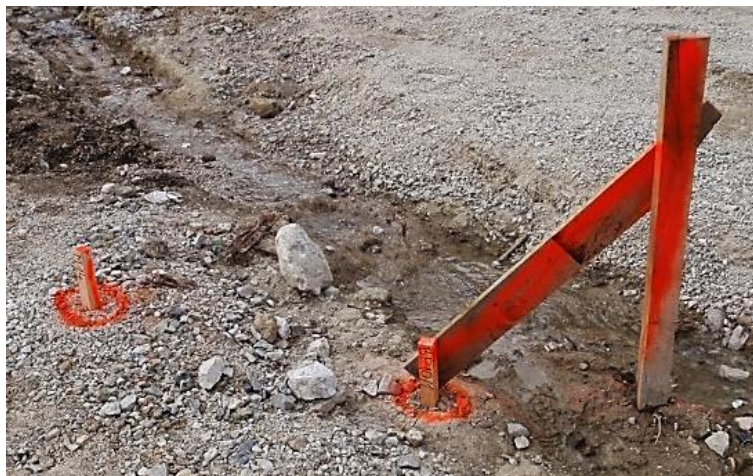
Slika 29: Zakoličba za izkop gradbene jame (Rudis d.o.o., 2011)
