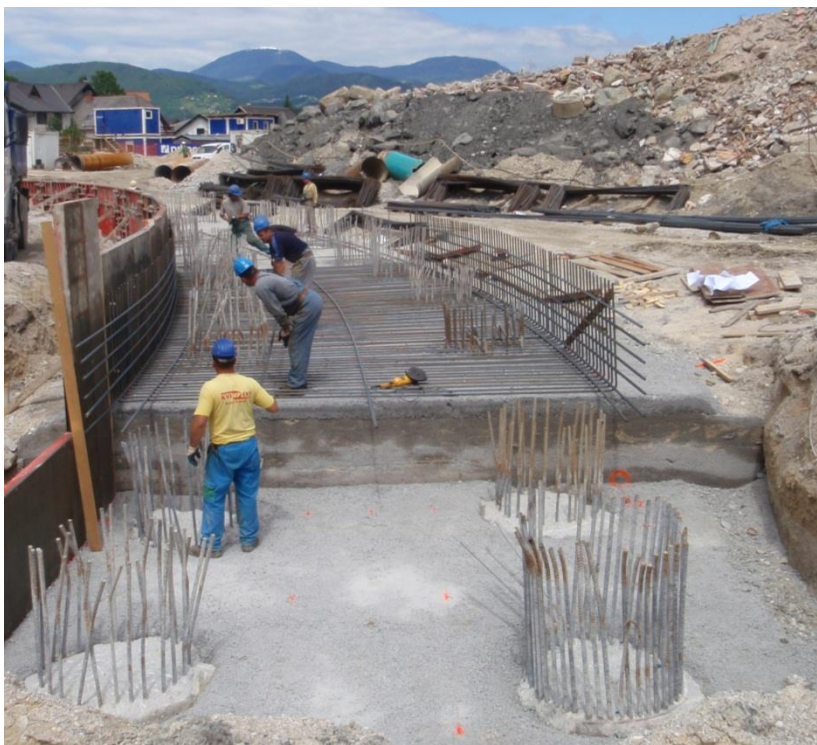
Slika 6: Betoniranje temeljev (Rudis d.o.o., 2011)
