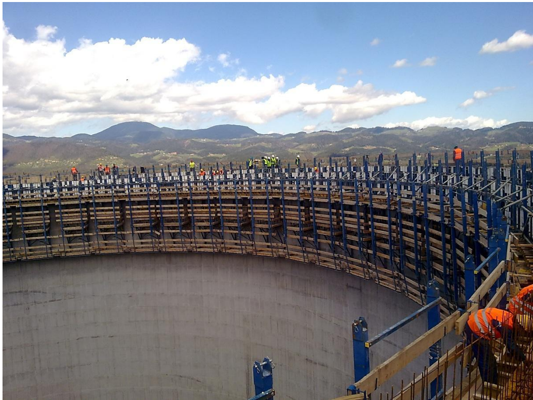
Slika 11: Opaž hladilnega stolpa (Rudis d.o.o., 2012)
