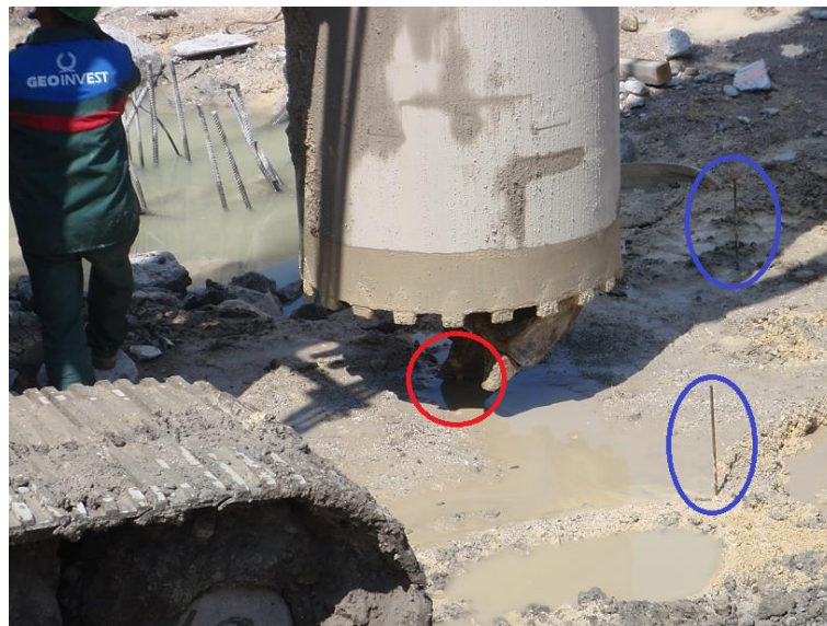
Slika 31: Postavitev stroja za izkop temelja nad zakoličeno točko (Rudis d.o.o., 2011)
