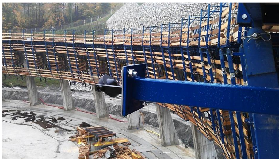
Slika 13: Prizma na merski letvi opaža (Rudis d.o.o., 2011)
