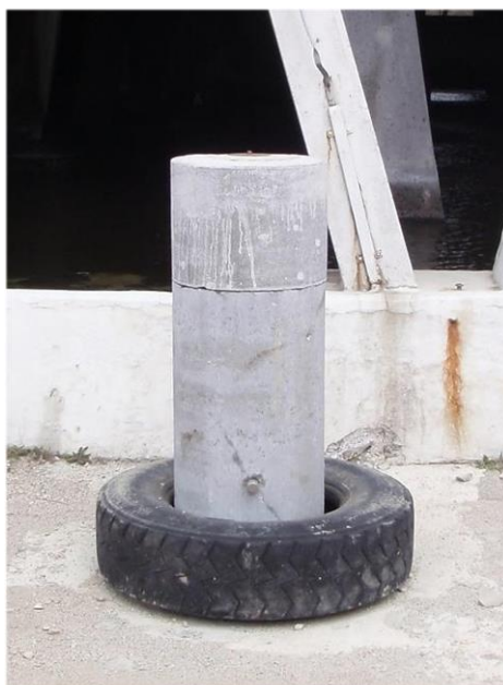
Slika 23: Položajna geodetska točka S1 in reper RS1 (Rudis d.o.o., 2011)
