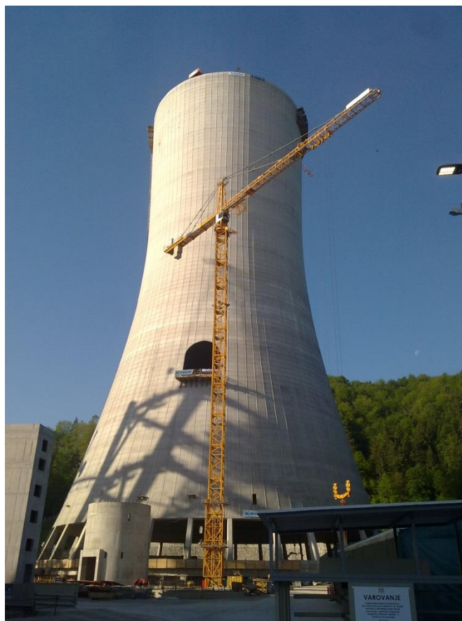
Slika 4: Hladilni stolp po končani gradnji lupine (Rudis d.o.o., 2012)
