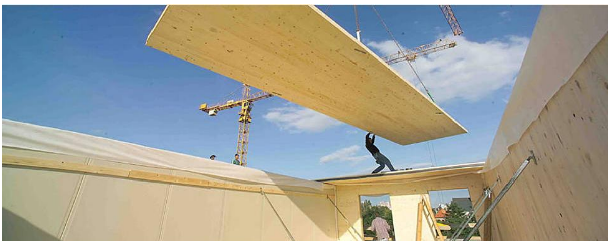
Slika 7: Montaža križno lepljenih plošč na gradbišču ( www.cbd.si )
