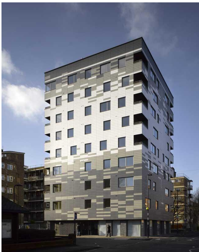
Slika 1: 9 nadstropna stanovanjska stavba iz križno lepljenih plošč v Londonu
