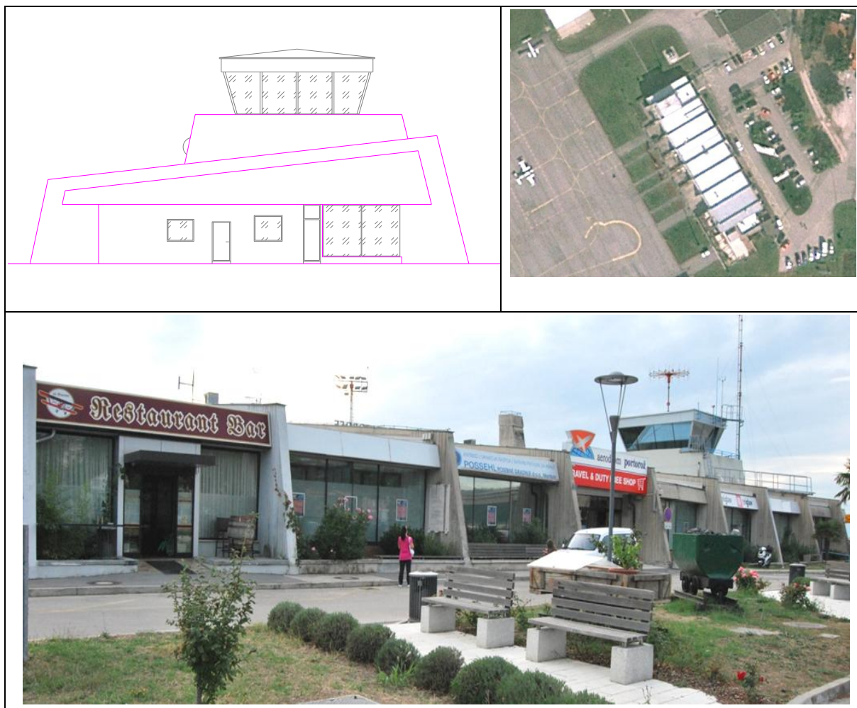
Slika 3: SZ fasada, lokacija stavbe in realni izgled obravnavane stavbe.
