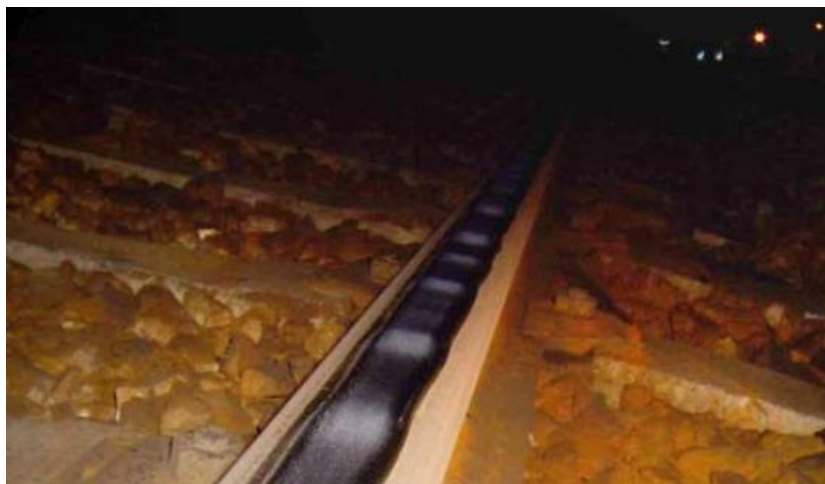
Slika 16: Prikaz rebričenja tirnice [24]
