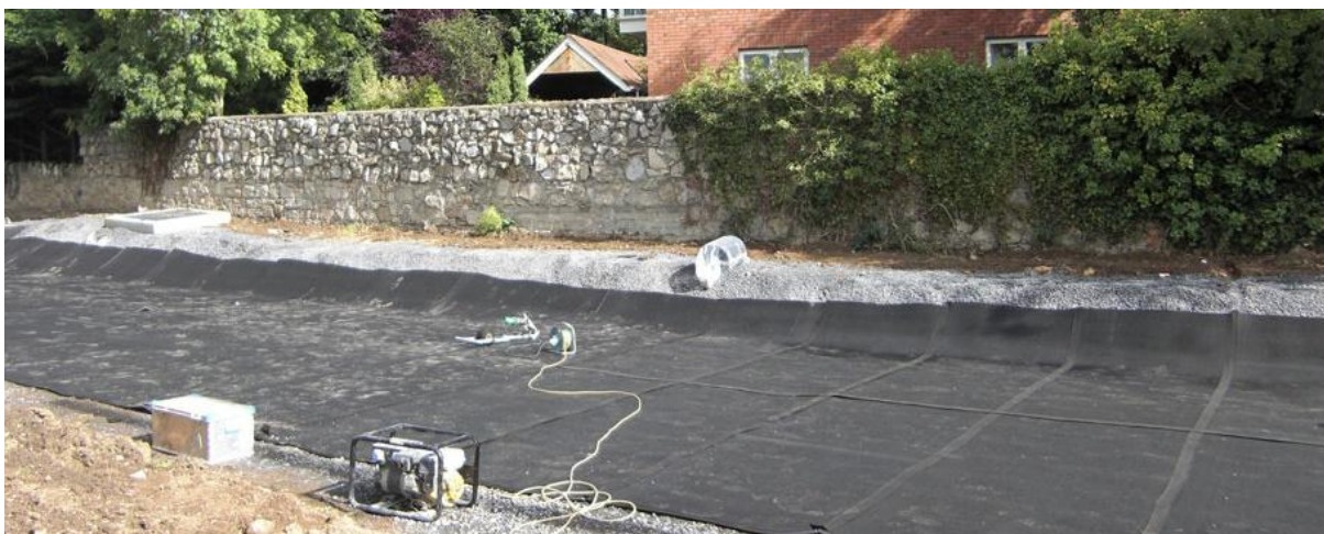
Slika 48: Namestitev balastnih žimnic [40]
