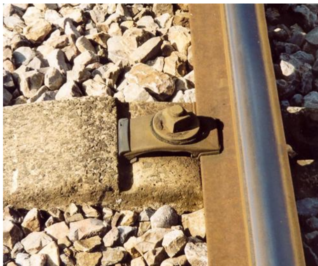
Slika 31: Sistem elastične ploščice RN [34]
