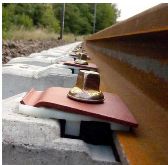
Slika 32: Elastična ploščica NABLA [35]
