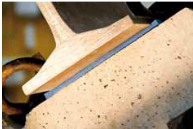
Slika 47: Podložna plošča med tirnico in betonskim pragom [38]
