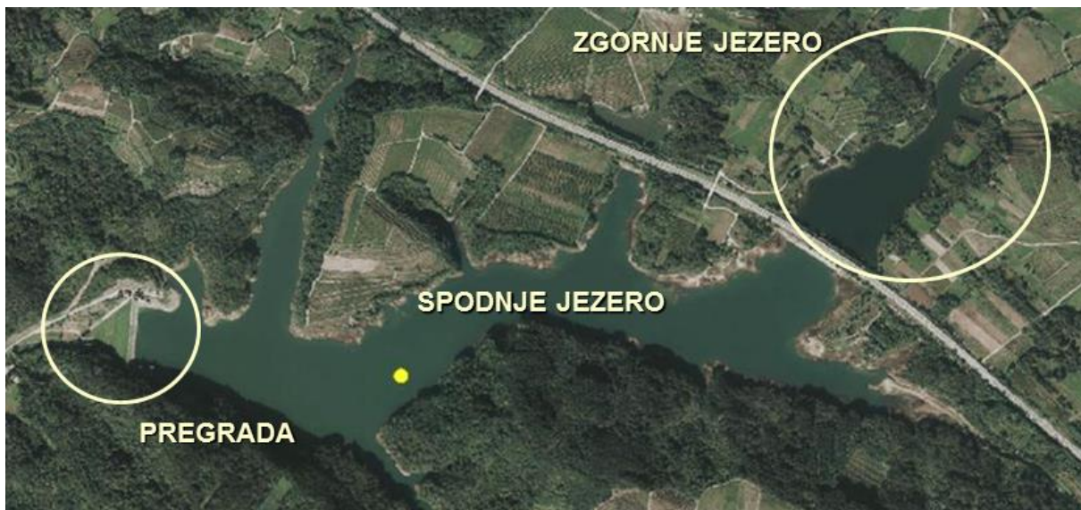
Sl. 3: Akumulacija Vogršček s pregrado, spodnjim jezerom in zgornjim jezerom, [5]
