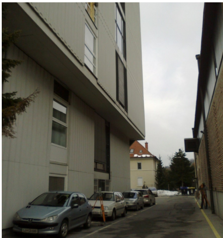
Slika 6: Postavitev lesene konstrukcije in zenitlota
