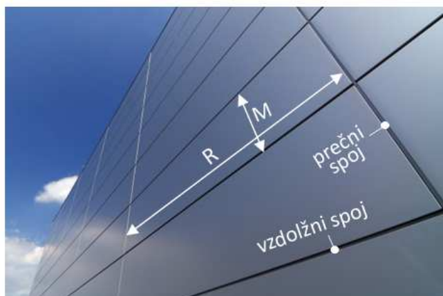
Slika 5: Horizontalna vgradnja fasadnih elementov
