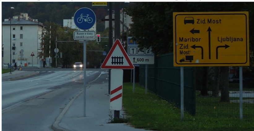
Slika 17: Primer neustreznega prometnega znaka za razvrŖanje vozil z imeni krajev (III-85.1).
