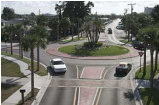
Slika 15: Barvani robniki otokov in obroba z neprekinjeno črto. [37]
