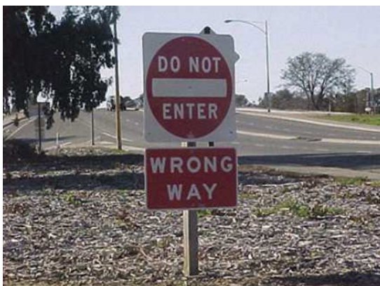
Slika 32: Nižje montirani znaki za preprečevanje vožnje v napačno smer. ([39]: str. 8)
