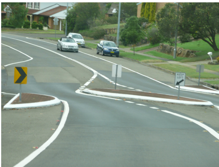
Slika 45: Barvani otoki v Sydneyju, dodatno obrisani s talno označbo in označeni z izbočenimi markerji. (Vir: lasten)
