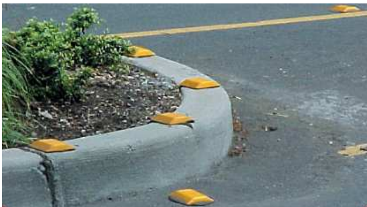
Slika 44: Retrorefleksivni markerji na robnikih. ([32]: str. 15)
