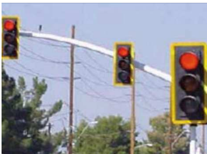
Slika 48: Reflektna obroba semaforške glave. ([35]: str. 3)
