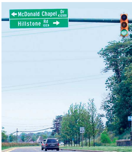
Slika 36: Tabla z imeni prihajajočih ulic postavljena nad prometni pas. ([32]: str. 8)
