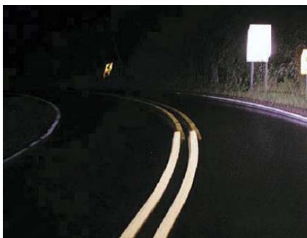
Slika 40: Prikaz vidljivosti širših ločilnih črt s steklenimi kroglicami v mokrih nočnih pogojih. ([39]: str. 11)
