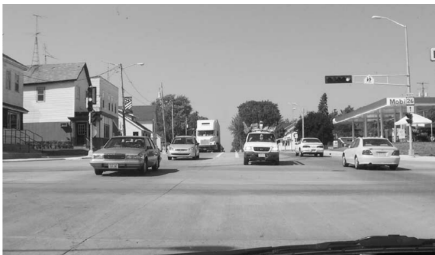
Slika 10: Izboljšana preglednost s pozitivnim zamikom pasov za leve zavijalce. ([42]: str. V-21)
