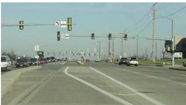
Slika 50: Postavitev semaforjev nad vsakim prometnim pasom. ([39]: str. 16)
