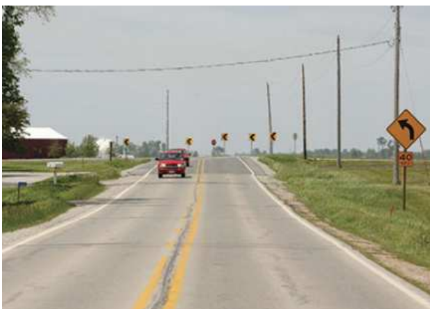
Slika 54: Table za usmerjanje v horizontalnih krivinah. ([39]: str. 3)
