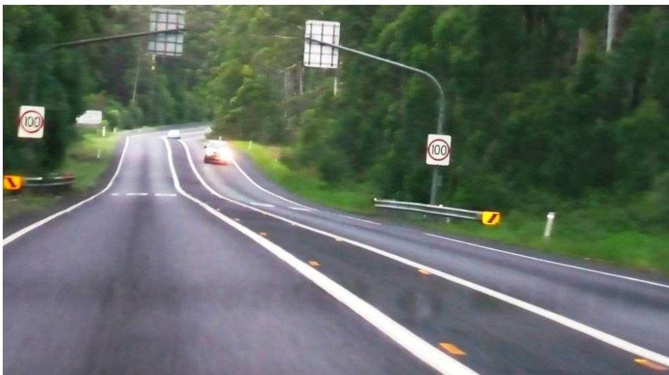
Slika 52: Poudarjanje horizontalnih krivin z reflektnimi markerji in dvojno ločilno črto. (Vir: lasten)
