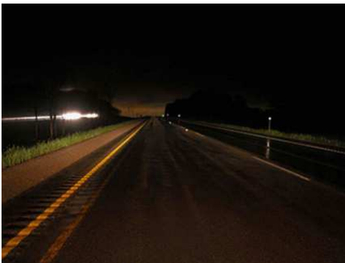
Slika 43: Barvan zarezan asfalt izboljšuje retrorefleksijo robnih in sredinskih črt v mokrih nočnih pogojih. ([39]: str 14)
