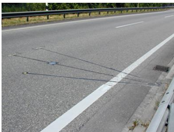
Slika 17: Talne sonde vgrajene v obrabno plast cestišča (Boschung, 2013)
