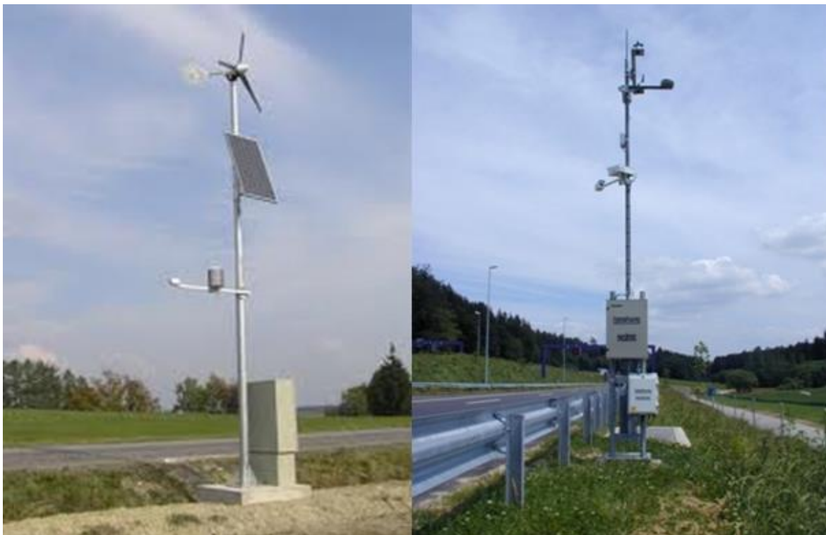
Slika 15: Cestno vremenski postaji (Boschung, 2013)
