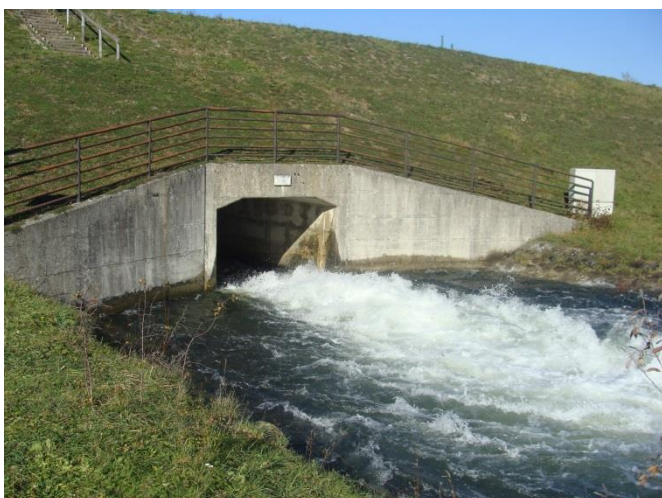
Slika 4: Talni izpust (foto: Mušič, 2012)
