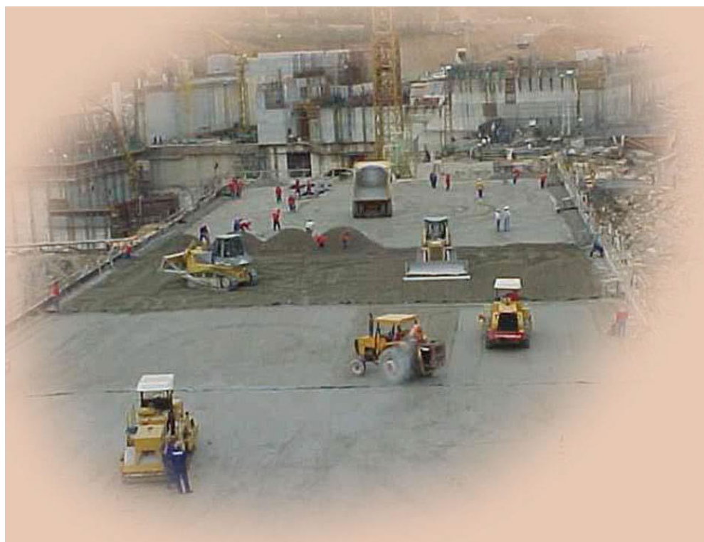
Slika 19: Prikaz gradnje s tehnologijo valjanega betona [8]
