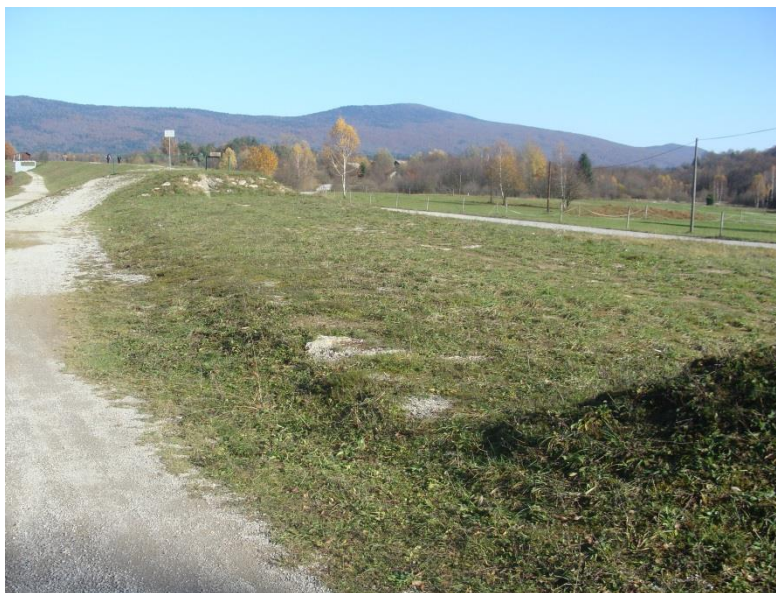
Slika 12: Prag varnostnega preliva z vodne strani pregrade (foto: Mušič, 2012)
