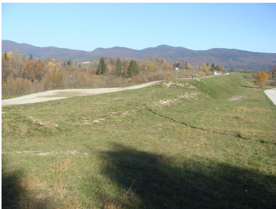
Slika 9: Varnostni preliv z zračne strani pregrade (foto: Mušič, 2013)
