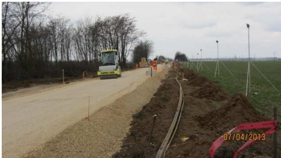
Slika 33: Zgoščanje proge z valjarji (Obnova železniške proge odsek Lipovci – Murska Sobota, 2013)
