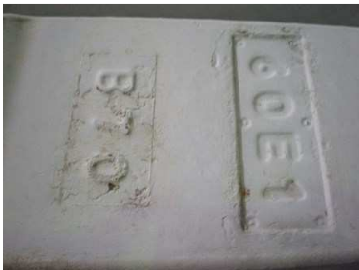
Slika 8: Označitev betonskih pragov (lasten vir)
