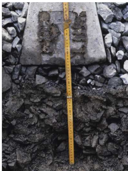
Slika 18: Drobljenje tolčenca in zapolnitev praznin z zdrobljenimi delci (Ballast Properties, 2013)
