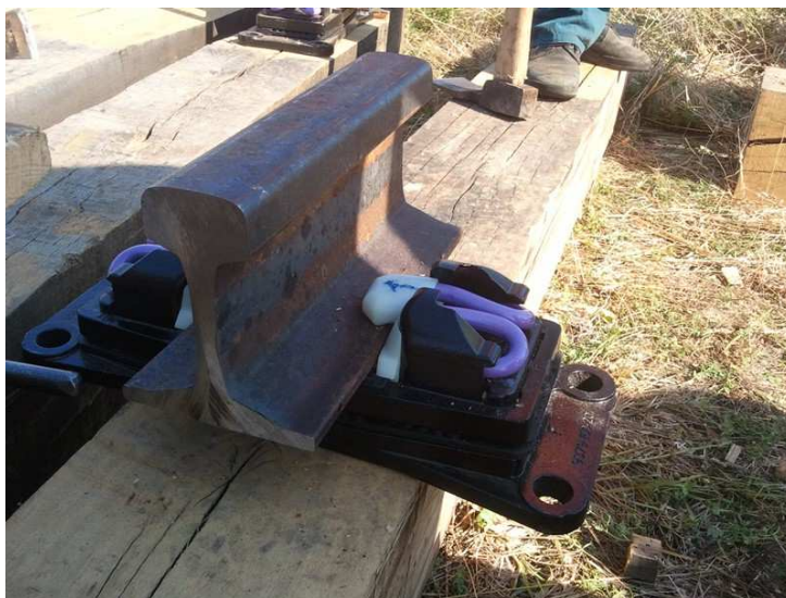
Slika 13: Del tirnice s sistemom elastične pritrditve Pandrol za lesene prage (lasten vir)
