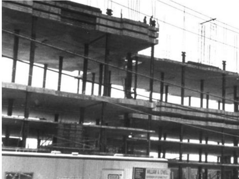
Slika 1.4: Gradnja stavbe L'Ambience Plaza
