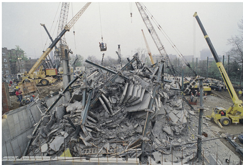
Slika 1.5: Katastrofalne posledice porušitve stavbe L'Ambience Plaza
