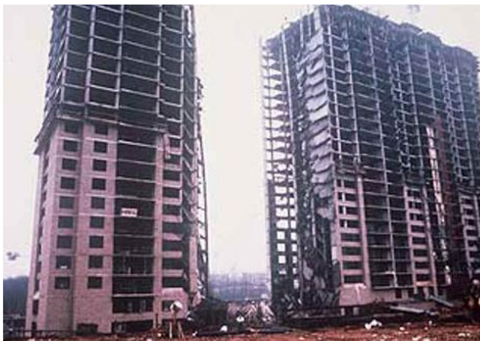
Slika 1.3: Porušitev stavbe Skyline Plaza
