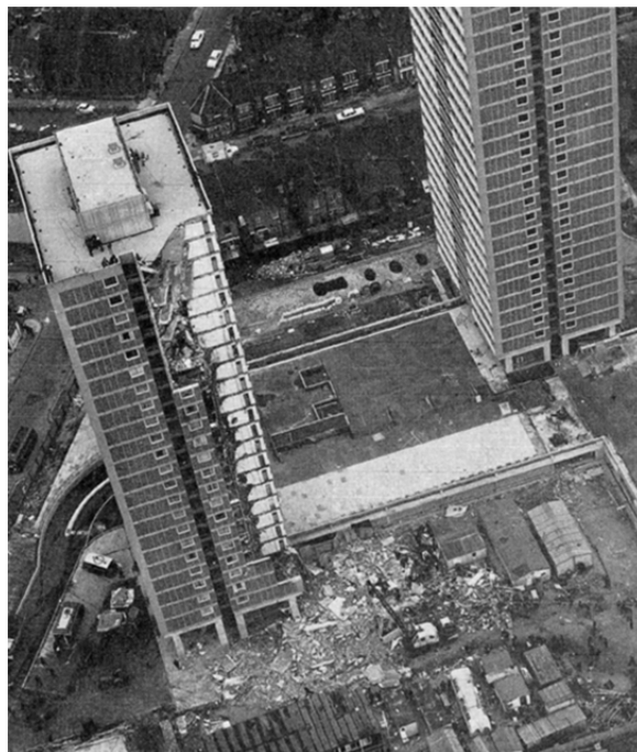
Slika 1.2: Nesorazmerna porušitev stolpnice Ronan Point
