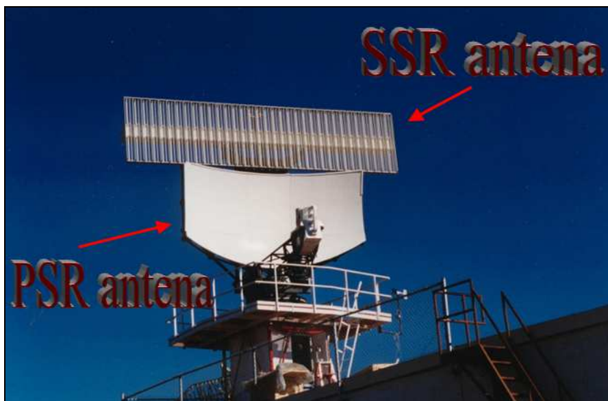
Slika 17: Prikaz SSR in PSR anteni, uporabljen predvsem v letalstvu
