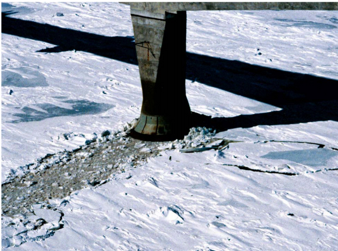
Slika 8: Steber glavnega mostu z unikatnim stožčastim ščitnikom (Campell Scientific, 2003)
