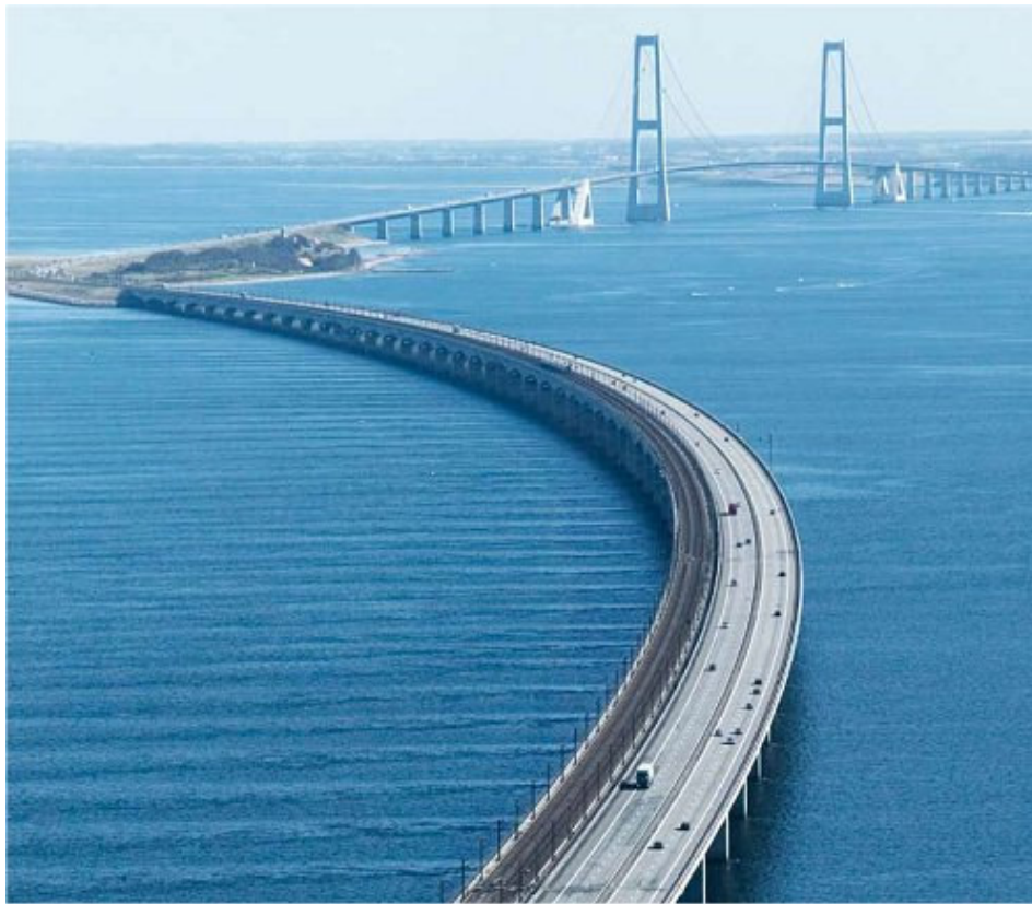
Slika 11: Pogled na vzhodni most in otoček Sprogø. Lepo so vidni vsi elementi mostu - sidrna bloka, pilona, kabli, stebri in voziščni nosilec (Sund & Baelt, 2006)
