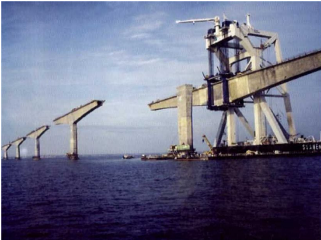
Slika 9: Edinstveni 100 metrski žerjav Svanen namešča glavni nosilec na steber; med že postavljenimi nosilci pa je viden razmak, ki je namenjen spuščnim nosilcem (Group SCI, http://www.groupsci.com/images/SVANEN.jpg )
