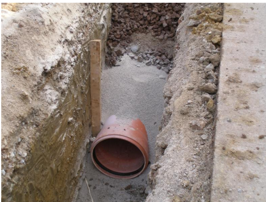
Slika 1: Vgradnja kanalizacijske cevi (Gitnik, 2013)
