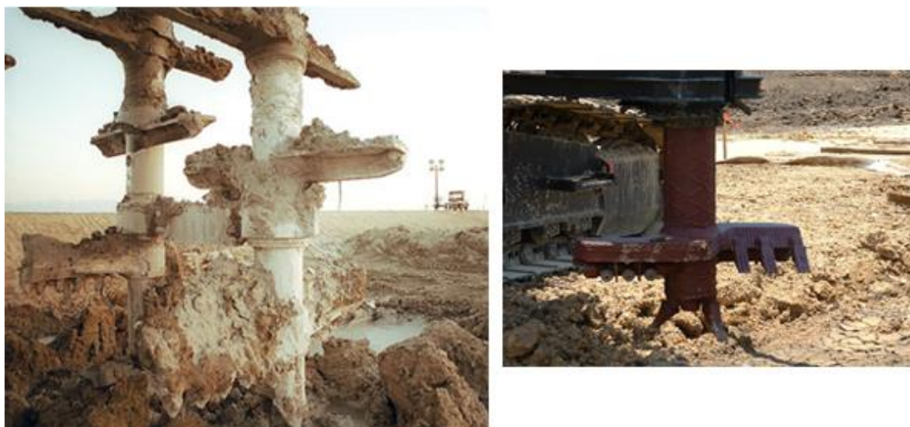
Slika 16: Mešalke za mokro mešanje ( http://texas.construction.com in http://www.entact.com ).
