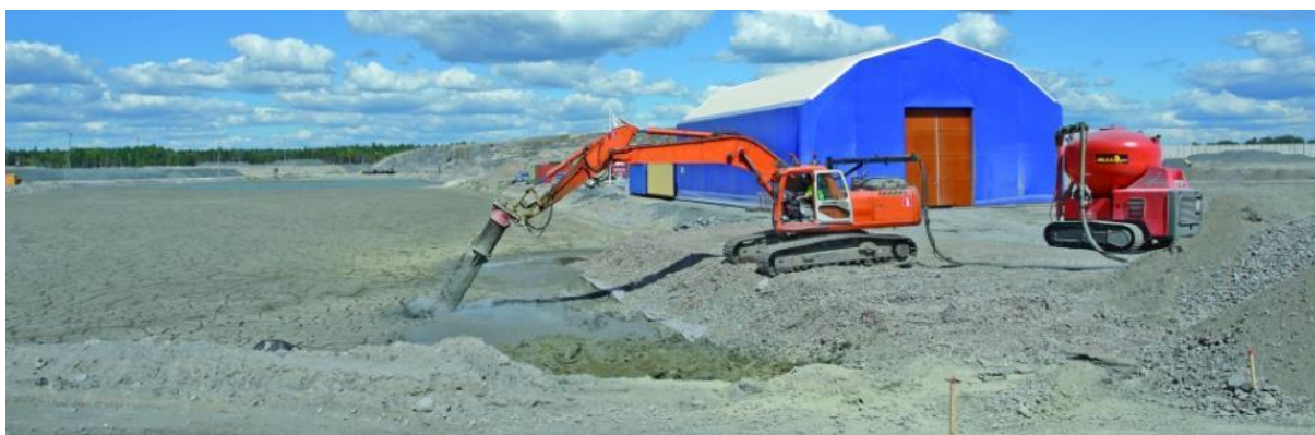
Slika 17: Površinsko mešanje, stabiliziranje bloka ( http://www.haywardbaker.com ).
