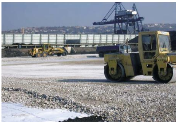
Slika 35: Gradnja zgornjega ustroja površine za skladiščenje in pretovor premoga (Logar, 2010: str. 110).
