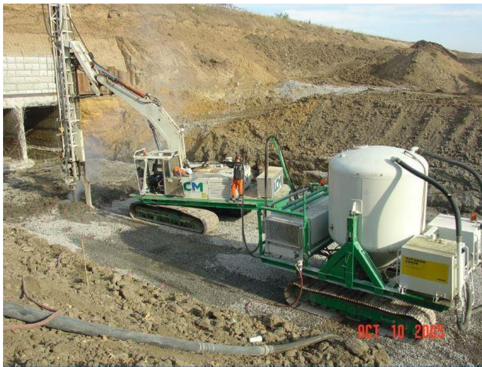
Slika 1: Izvedba globinskega mešanja (Schleter, 2007: str. 44).
