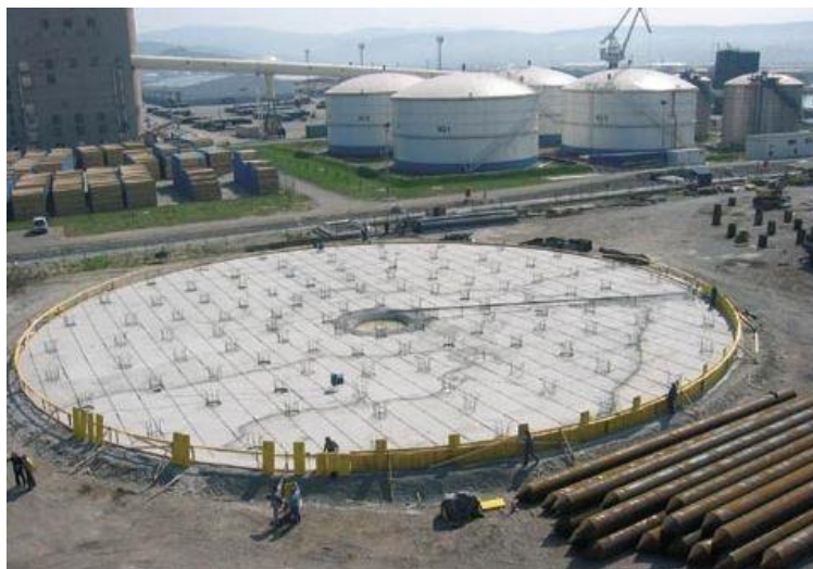
Slika 36: Temeljna plošča rezervoarja R-09 med gradnjo (Logar, 2010: str 113).
