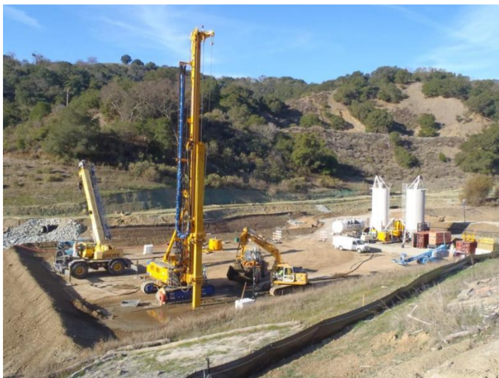
Slika 10: Mešalni obrat s silosi veziva, katerega se preko cevi dovaja do mešalne naprave ( http://wsipsunolvalley.blogspot.com/2011_12_01_archive.html ).
