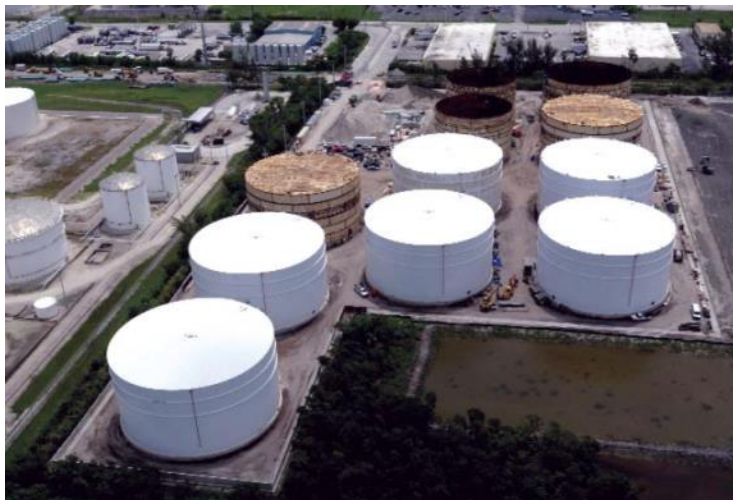
Slika 30: Gradnja rezervoarjev v Port Everglades na stabiliziranih tleh (Hayward Baker, 2009: str. 1).
