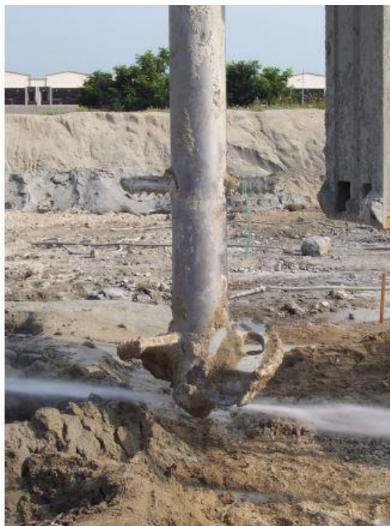
Slika 26: Izvajanje globinskega mešanja na področju čistilne naprave Jelutong (Raju, 2008: str. 9).
