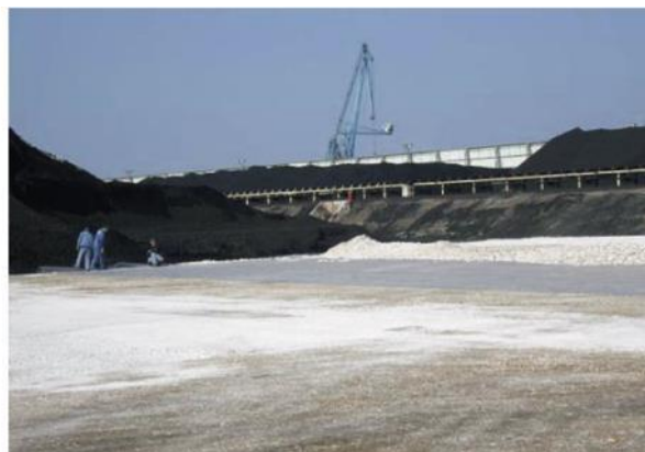
Slika 35: Gradnja zgornjega ustroja površine za skladiščenje in pretovor premoga (Logar, 2010: str. 110).
