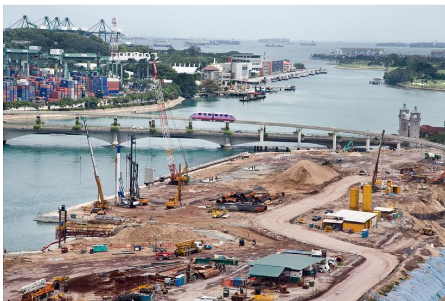
Slika 9: Organizacija gradbišča kjer potekajo dela globinskega mešanja za izboljšanje temeljnih tal v Singapurju ( http://www.keller.co.uk ).
