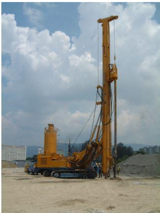
Slika 26: Izvajanje globinskega mešanja na področju čistilne naprave Jelutong (Raju, 2008: str. 9).
