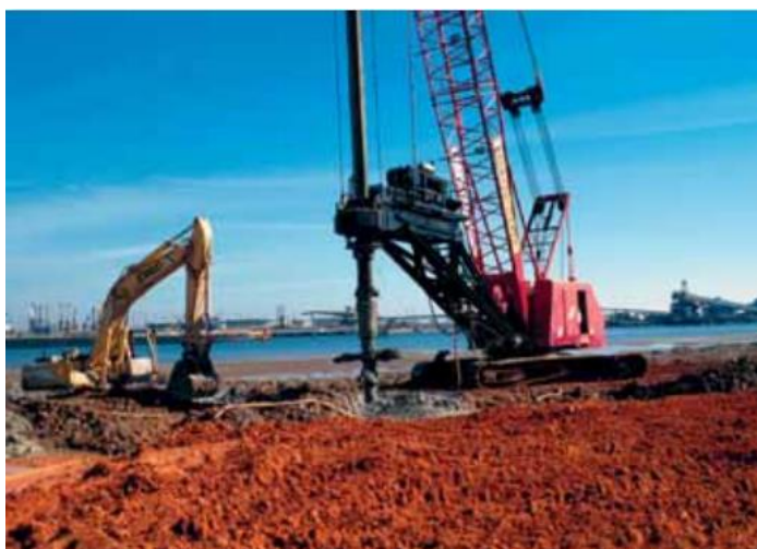
Slika 31: Izvedba globinskega mešanja (Hayward Baker, 2008: str. 1).
