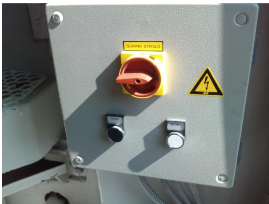
Slika 11: Elektroomarica s stikali za upravljanje ribje steze
