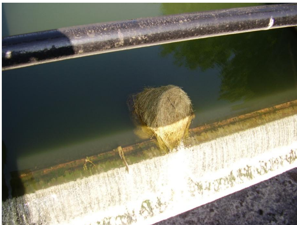
Slika 14: Zatkanje plavja na prelivnem robu zgornje table (bala sena)
