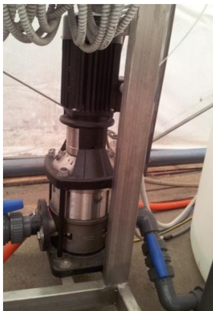
Slika 15: Centrifugalna črpalka PC2
