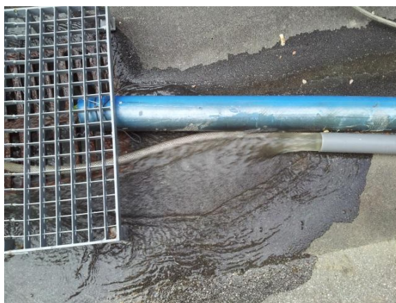
Slika 16: Iztoki membranske pilotne naprave, speljani po ceveh v jašek meteorne vode
