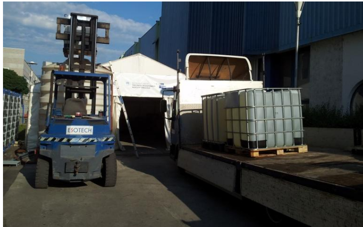
Slika 31: Polnjenje vstopnega rezervoarja (VG1) z načrpano površinsko vodo
