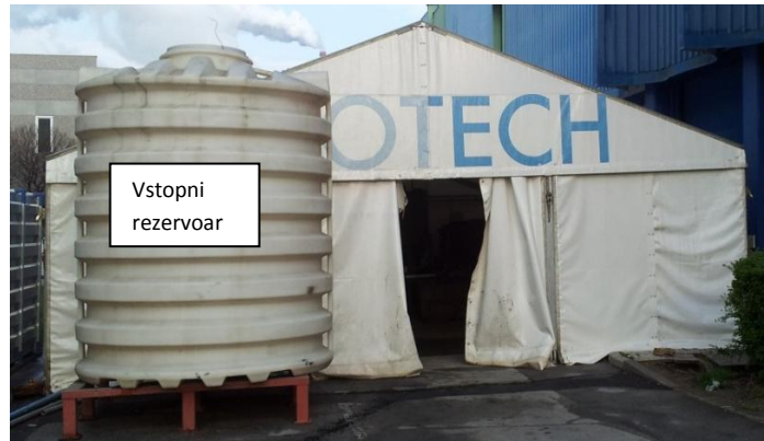
Slika 10: Vstopni 10 m 3 rezervoar vode
