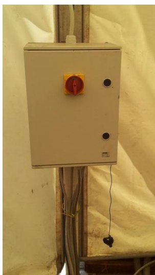
Slika 22: Glavne krmilna in napajalna električna omara
