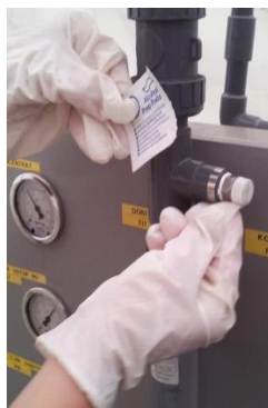
Slika 30: Dezinfekcija vzorčne pipice za odvzem RO permeata
