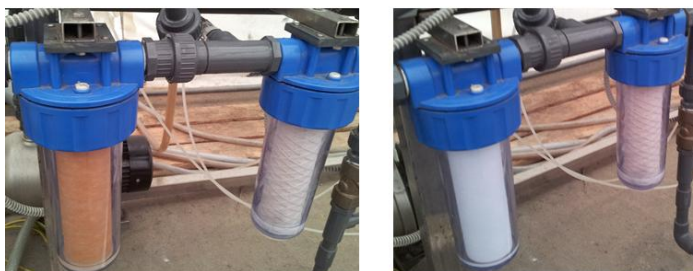
Slika 26: Zamenjava svečnih filtrov z novimi (Levo: stara filtra, Desno: nova filtra)
