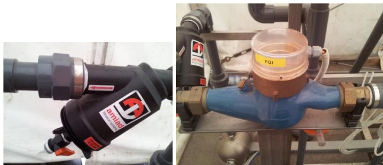
Slika 13: Sitast 0,13 mm filter (levo), vodomer FQ1 (desno)
