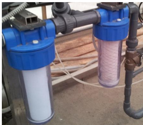
Slika 21: Svečni 5-mikronski (levi) in 1-mikronski filter (desni)
