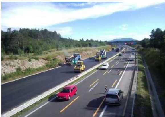
Slika 28: Vgrajevanje asfaltne plasti na avtocestnem odseku Divača – Kozina (Vir: [15])
