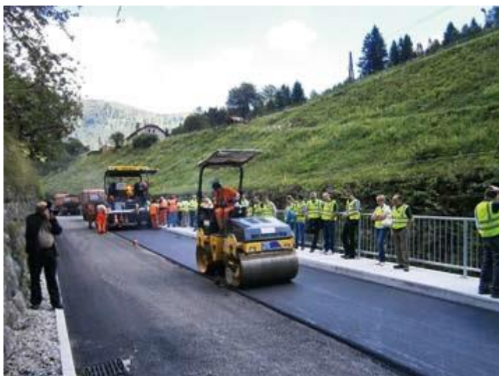
Slika 30: Vgrajevanje asfaltni plasti z zrnji žindre (projekt ReBirth) (Vir: [16])
