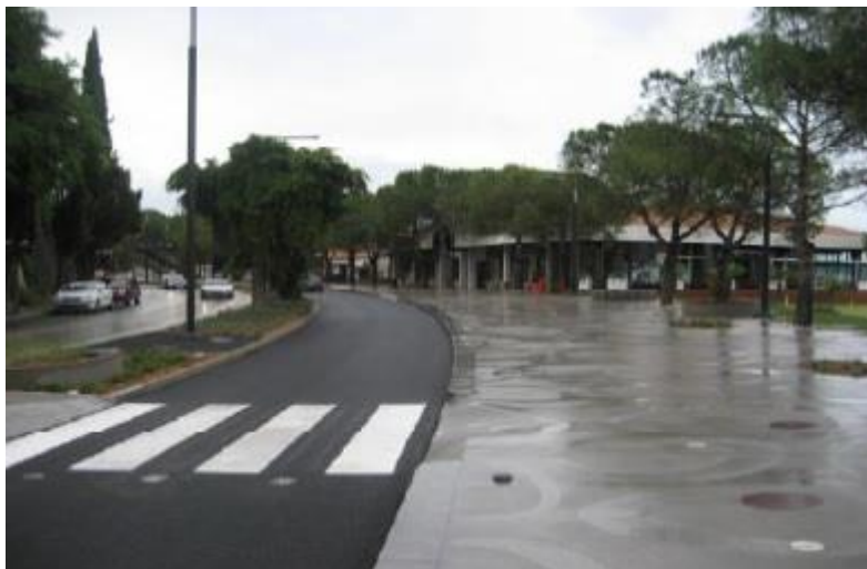
Slika 29: Vgrajen drenažni asfalt na cesti Portorož – Lucija (Vir: [15])
