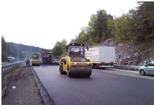
Slika 27: Vgrajevanje asfaltne plasti na avtocestnem odseku Vrhnika – Logatec (Vir: [15])
