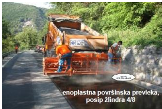
Slika 26: Vgrajena enoplastna površinska prevleka s posipom zrn žindre (Vir: [6])
