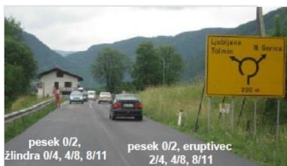
Slika 25: Vgrajeni dve različni plasti bitumenskega betona v Tolminu (Vir: [6])
