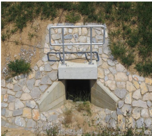
Slika 23: Vtočna glava prepusta na JC (vir: lastni, 2013).
