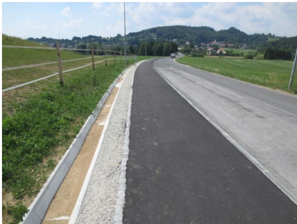
Slika 25: Obrabna asfaltna plast na JC (vir: lastni, 2013).
