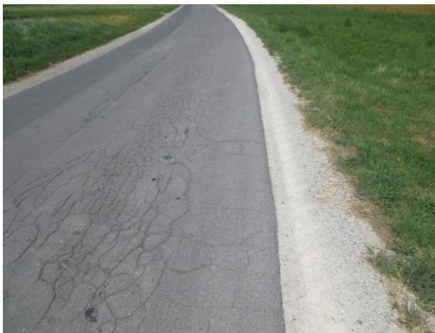
Slika 32: Mrežne razpoke na JC (vir: lastni, 2013).
