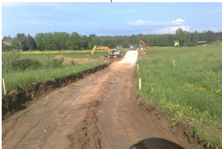
Slika 18: Izkop slabo nosilne zemljine in zamenjava z novo (vir: lastni, 2013).
