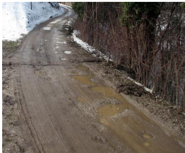
Slika 31: Udarne jame in poškodbe zaradi zmrzali na GC (vir: lastni, 2013).
