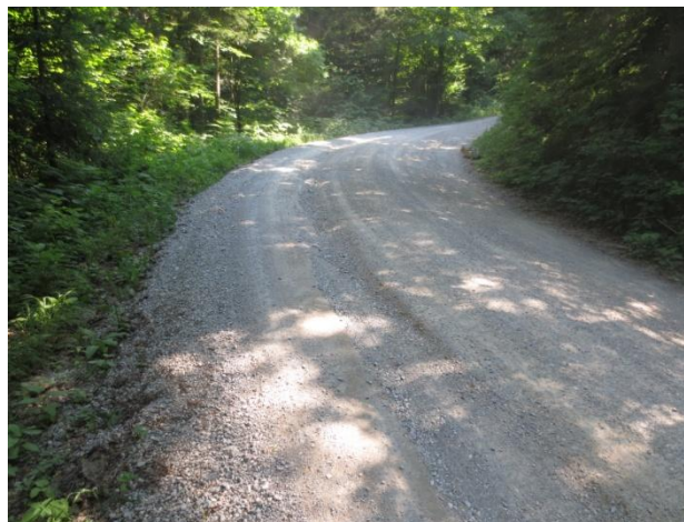
Slika 33: Žlebovi na GC (vir: lastni, 2013).
