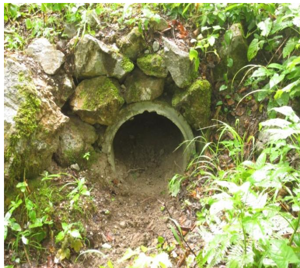
Slika 24: Iztok iz prepusta na GC (vir: lastni, 2013).
