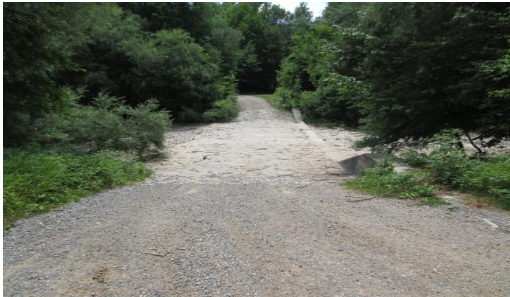
Slika 16: Prečenje vode z utrjenim voziščem (vir: lastni, 2013).
