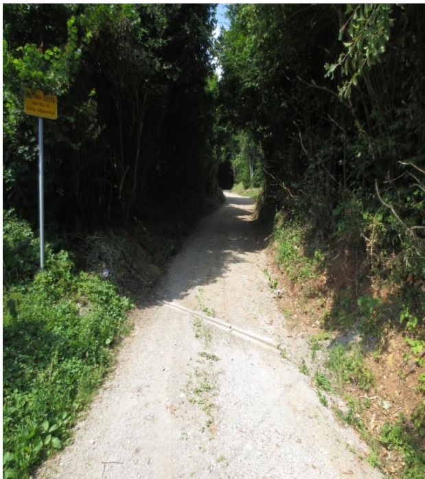
Slika 5: Ustrežno izvedeno odvajanje površinske vode na priključku z JC – drežnik (vir: lastni, 2013).
