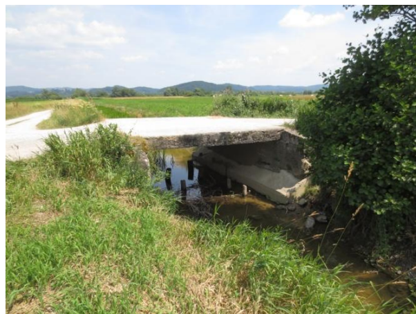
Slika 20. Izvedba mostu na GC (vir: lastni, 2013).
