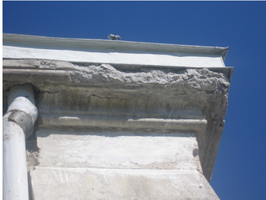
a) Drežnica - Cerkev sv. Srca Jezusovega. Poškodbe simsa zaradi neustrezne izvedbe ali poškodovanosti žlebov (foto: Štampfl, A., 2010).
