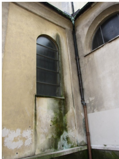
a) Ljubljana - Cerkev sv. Petra. Močno zamakanje ob okenski odprtini (Bosiljkov, Gostič, 2009).
