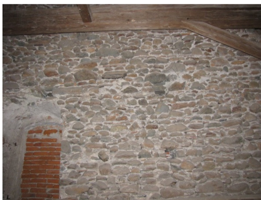
e) Ruše - Cerkev Matere božje. Struktura zidov na podstrešju (Bosiljkov, Gostič, 2009).
