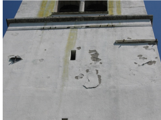
b) Kobarid - Cerkev sv. Antona Padovanskega. Poškodbe na fasadi zvonika zaradi zatekanja meteorne vode z zvonišča (foto: Popović, M., 2006).
