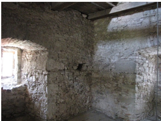
a) Gornji Grad - Cerkev sv. Mohorja in Fortunata. Struktura zidov v notranjosti zvonika (Bosiljkov, Gostič, 2009).
