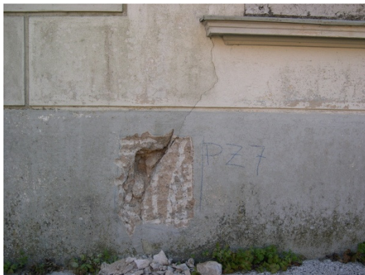
c) Postojna - Cerkev sv. Štefana. Preiskovalna sonda na zidu v območju razpoke (foto: Štampfl, A., 2005).
