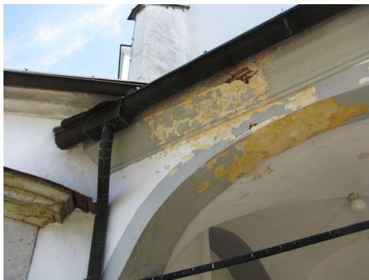
d) Nova Štifta - Cerkev Marijinega vnebovzetja. Poškodbe na simsu in loku v območju žleba (Bosiljkov, Gostič, 2009).
