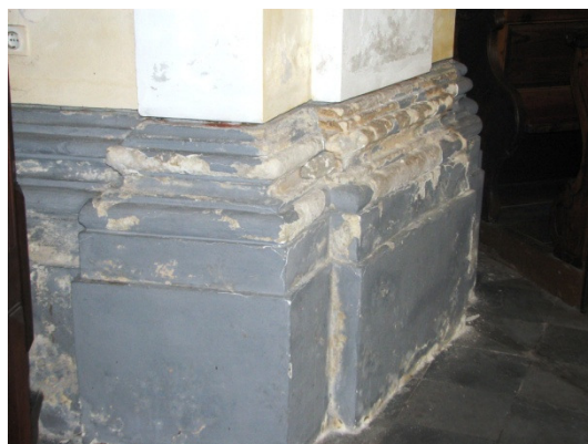
b) Maribor - Cerkev sv. Alojzija. Poškodbe zaradi kapilarne vlage na podzidku (Bosiljkov, Gostič, 2009).
