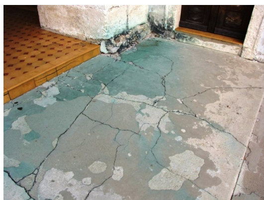
č) Svete gore - Cerkev Matere božje. Mrežaste razpoke v tlaku (Bosiljkov, Gostič, 2009).
