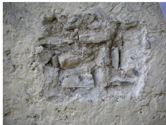
b) Kanalski Lom - Cerkev sv. Primoža in Felicijana. Preiskovalna sonda na zidu (foto: Popović, M., 2009).
