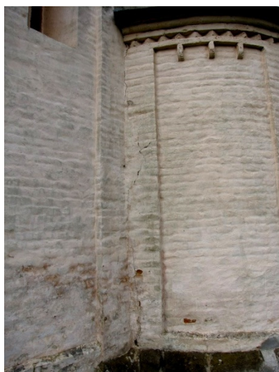
d) Selo na Goričkem - Cerkev sv. Nikolaja. Vertikalna razpoka na stiku apside z osnovnim delom objekta (Bosiljkov, Gostič, 2009).
