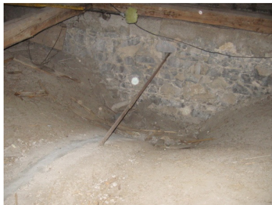
b) Drežnica - Cerkev sv. Srca Jezusovega. Betonski obok (foto: Štampfl, A., 2010).
