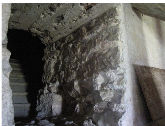
č) Nova Štifta - Cerkev Marijinega vnebovzeta. Struktura zidov ob odprtini (Bosiljkov, Gostič, 2009).
