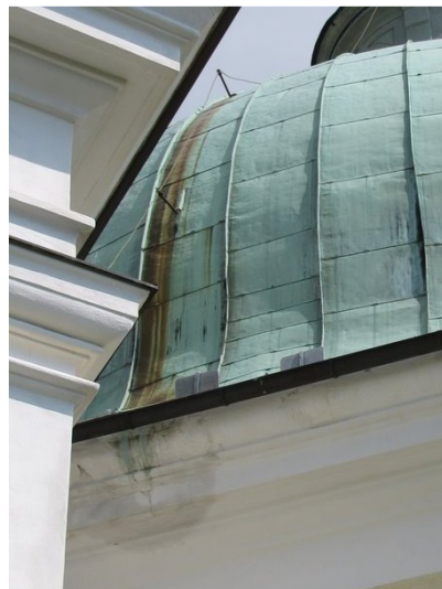
č) Tunjice - Cerkev sv. Ane. Sledovi zamakanja na simsu (Bosiljkov, Gostič, 2009).
