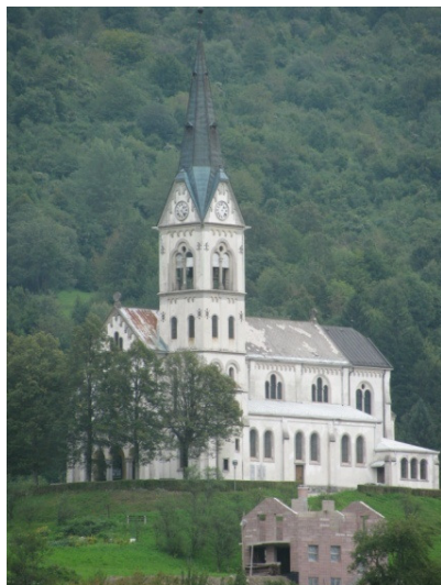
a) Drežnica - Cerkev sv. Srca Jezusovega, J fasada (foto: Podgornik, B., 2009).
