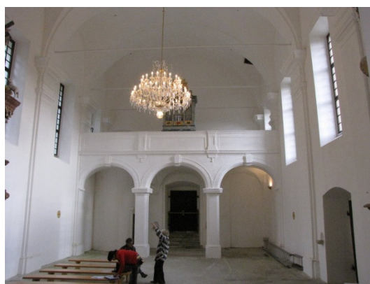
č) Rogatec - C. sv. Hiacinte, pogled proti vhodu. Kor za pevce (pevska empora), banjasto obokan strop (Bosiljkov, Gostič, 2009).
