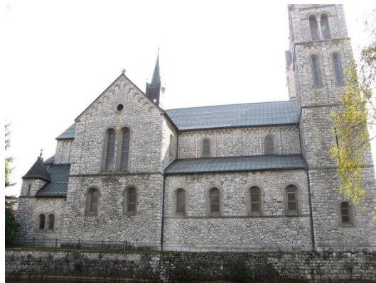
b) Kočevje - Cerkev sv. Jerneja. Struktura zidov na neometani fasadi (Bosiljkov, Gostič, 2009).
