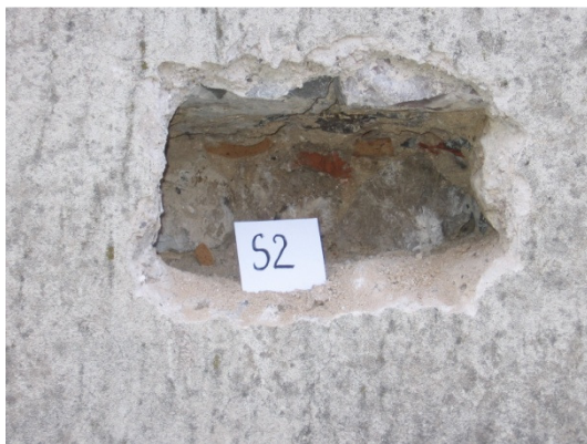
a) Drežnica - Cerkev sv. Srca Jezusovega. Preiskovalna sonda na zidu (foto: Štampfl, A., 2010).
