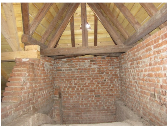
d) Murska Sobota - Cerkev sv. Nikolaja. Struktura zidov na podstrešju (Bosiljkov, Gostič, 2009).
