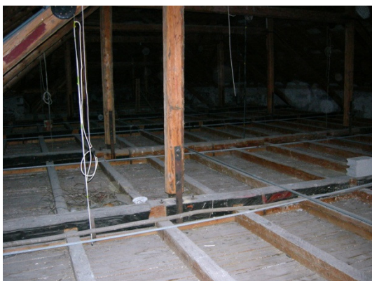
d) Bovec - Cerkev sv. Urha. Lesen raven strop (foto: Popović, M., 2006).
