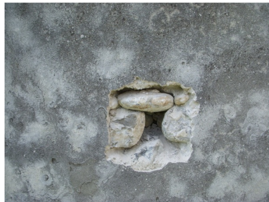
č) Tolmin - Cerkev sv. Urha. Preiskovalna sonda na zidu (foto: Popović, M., 2009).
