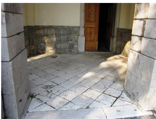
c) Log pri Vipavi - Cerkev Matere božje Tolažnice žalostnih. Poškodbe v tlaku (Bosiljkov, Gostič, 2009).
