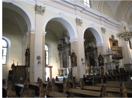
b) Brezje - C. sv. Vida. Bočne kapele (stebri se podaljšajo v prečne stene), (Bosiljkov, Gostič, 2009).
