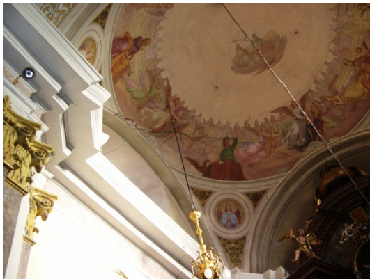
d) Postojna - Cerkev sv. Štefana. Razpoke na kupoli (foto: Štampfl, A., 2005).
