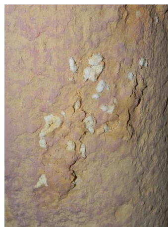
Slika 26: Pojav kristalizirane soli v cerkvi sv. Radegunde.
