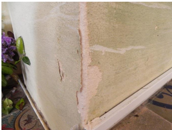
Slika 14: Luščenje ometa na zidu v cerkvi sv. Radegunde.
