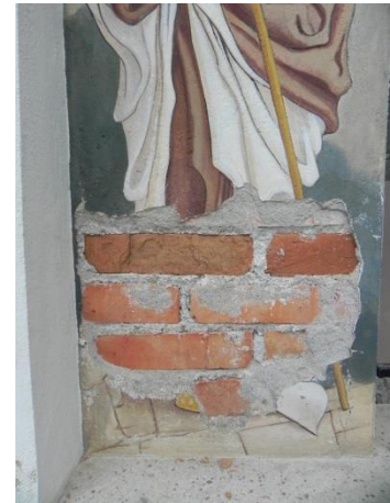
Slika 20: Ločevanje ometa od primarnega materiala, uporabljenega za nosilno konstrukcijo (kapelica).
