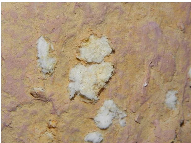
Slika 51: Fotografija petega merilnega mesta na cerkvi sv. Radegunde (pojav kristalizirane soli).
