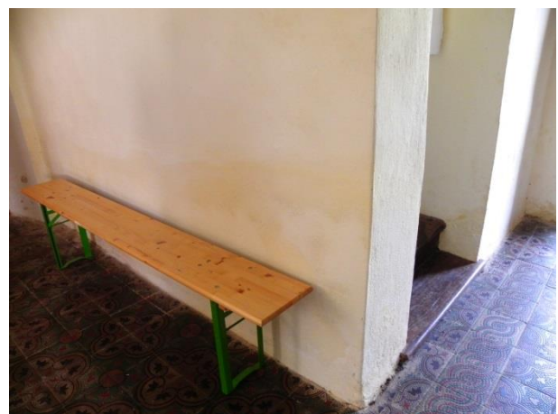
Slika 22: Vdor vlage v zidove v cerkvi sv. Radegunde, vidna je višina, do katere je voda prišla po zidovih.
