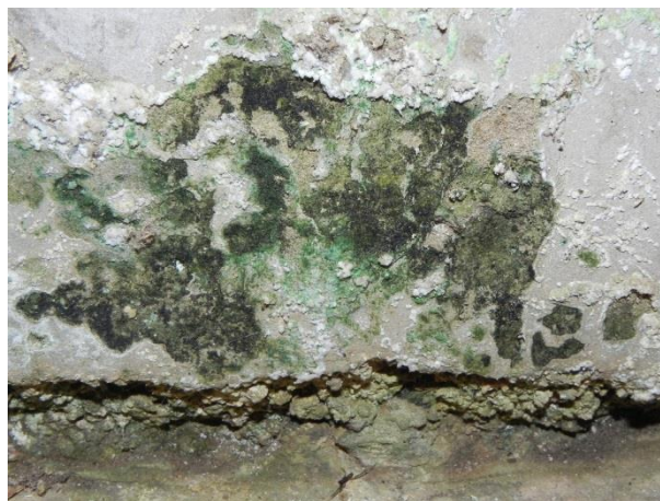
Slika 32: Pojav Biodegradacije in kristalizacija soli v cerkvi sv. Petra.
