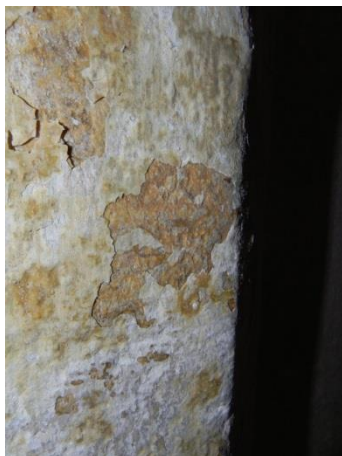
Slika 15: Luščenje ometa na enem izmed stebrov v cerkvi sv. Petra.
