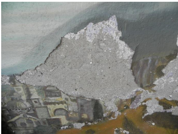
Slika 13: Luščenje ometa na kapelici, spodaj vidni ostanki predhodne poslikave.
