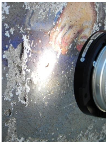
Slika 41: Fotografija drugega merilnega mesta na kapelici na Visokem pri Kranju (mehurjenje ometa).
