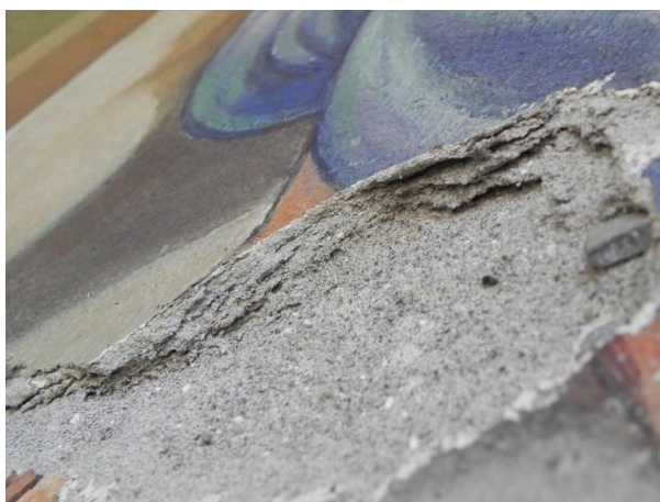
Slika 17: Rušenje ometa po plasteh na kapelici.
