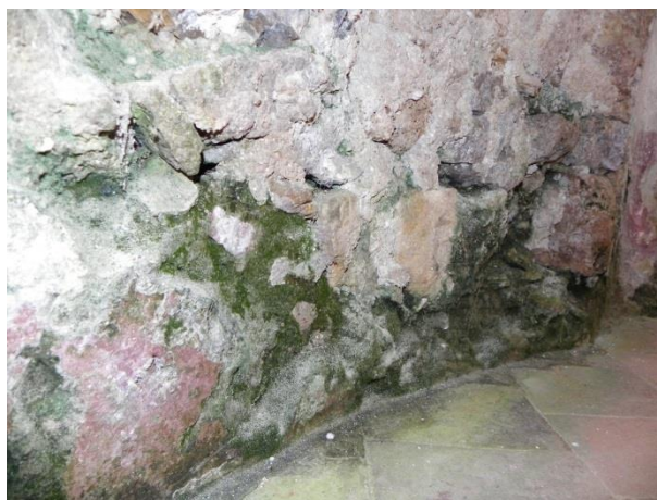
Slika 33: Pojav biodegradacije v cerkvi sv. Petra – sega veliko višje po zidovih kot na cerkvi sv. Radegunde in je mnogo obsežnejša.
