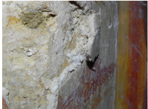
Slika 28: Pojav kristalizirane soli v cerkvi sv. Petra. Vidno je tudi odpiranje vrhnje plasti ometa zaradi kristalizacije.
