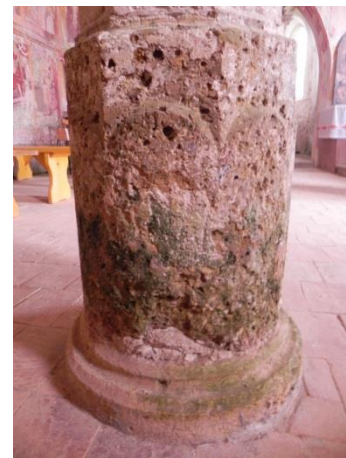
Slika 30: Razjede na stebri v cerkvi sv. Petra so v manjšem obsegu kot v cerkvi sv. Radegunde.
