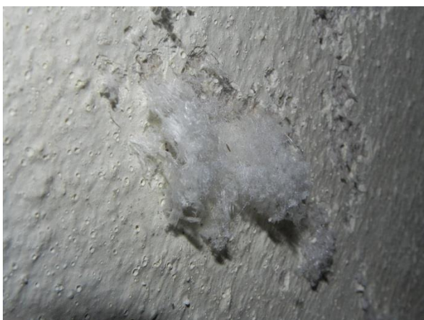
Slika 25: Pojav nitastih soli v cerkvi sv. Radegunde.
