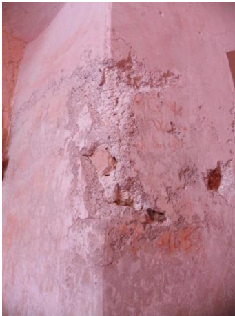
Slika 18: Ločevanje ometa od primarnega materiala, uporabljenega za nosilno konstrukcijo (cerkev sv. Petra).
