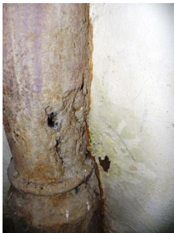
Slika 29: Vpliv dolgotrajne prisotnosti soli v cerkvi sv. Radegunde – globoke razjede, ki lahko vplivajo na nosilnost stebra.
