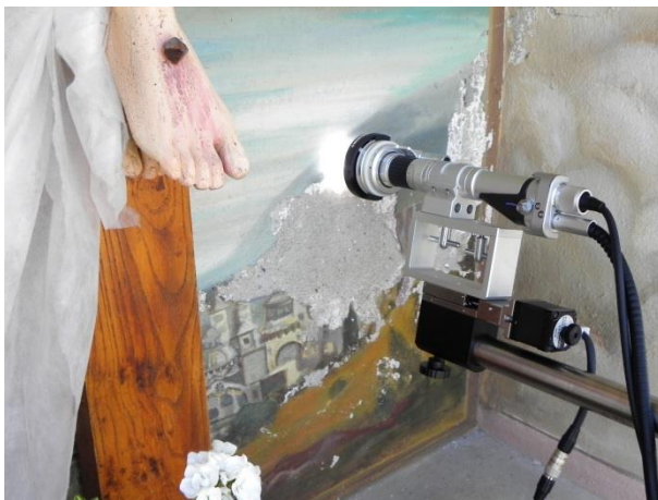
Slika 47: Fotografija četrtega merilnega mesta na kapelici na Visokem pri Kranju (luščenje zgornje plasti ometa).
